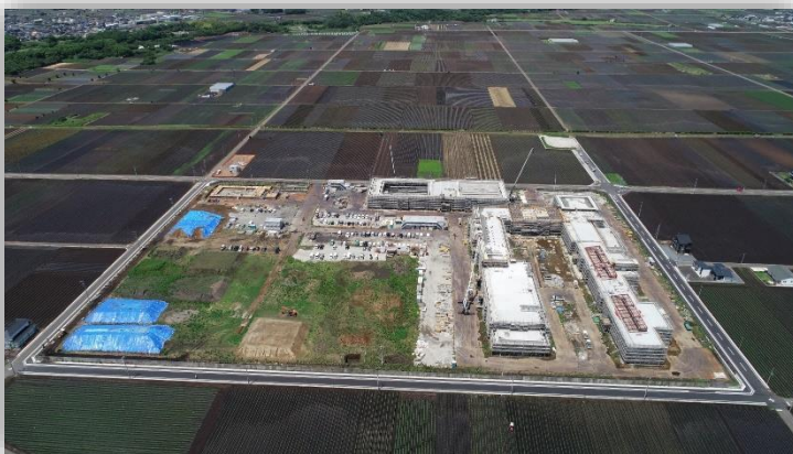
建設状況 令和2年6月撮影
