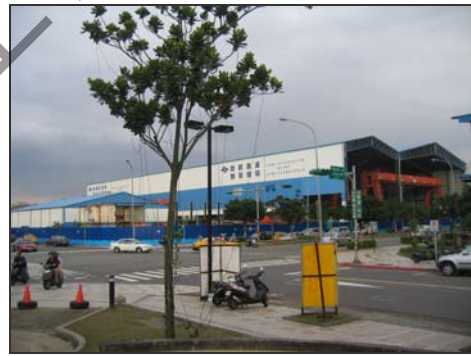
河濱高中預定地，現為捷運施工作業工廠
