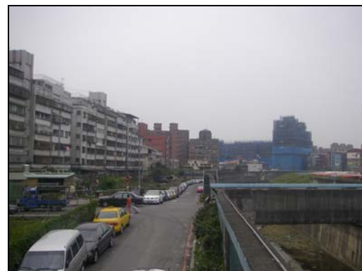
南望 SB11A 車站預定地 (汐止社后住宅區西側與內溝溪間)
