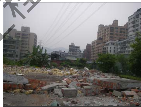
南望 SB12 站預定地
