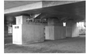
橋梁の耐震化（橋脚補強等）
