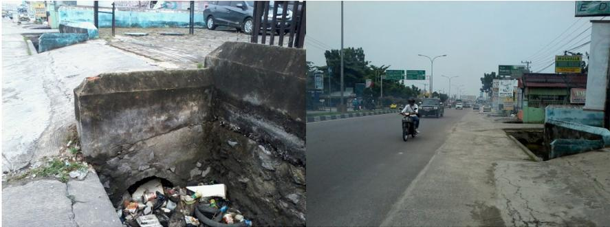
**Gambar 4.63.** Bekas banjir genangan (kiri) dan kondisi existing saluran drainase di Kecamatan Tampan (kiri dan kanan)
