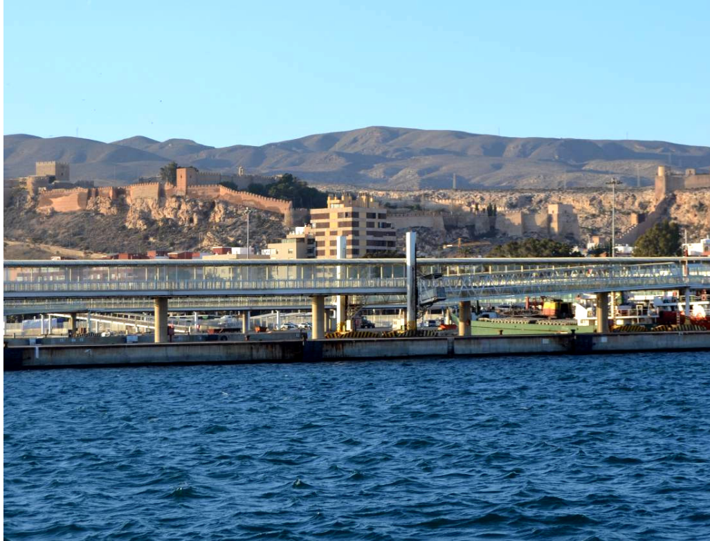
Figura 16. Fotografía desde el Puerto con la Alcazaba detrás [Fotografía: JFGS].
