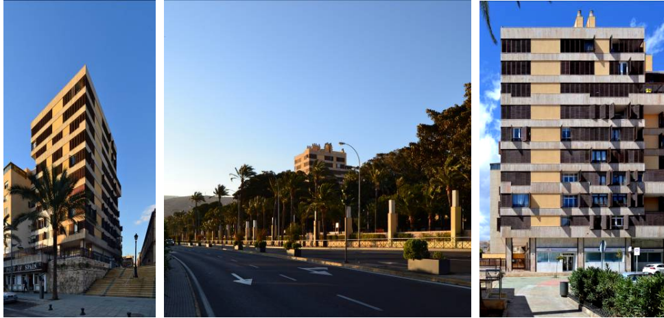
Figura 11. Fotografías del 'Edificio Parque' [Fotografías: JFGS].
