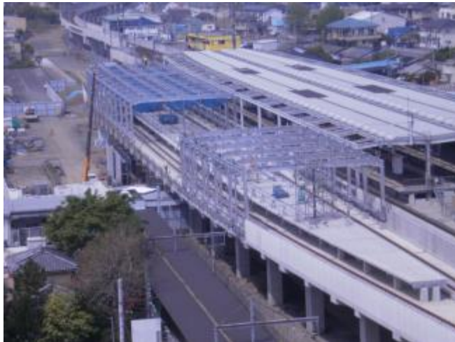
伊勢崎駅付近高架化工事
