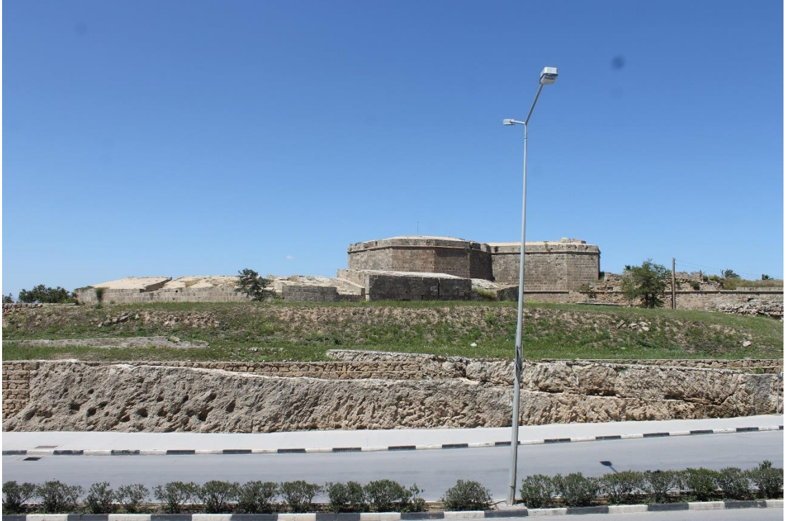
Ek 1d Ravelin ve kara giriş kapısı
