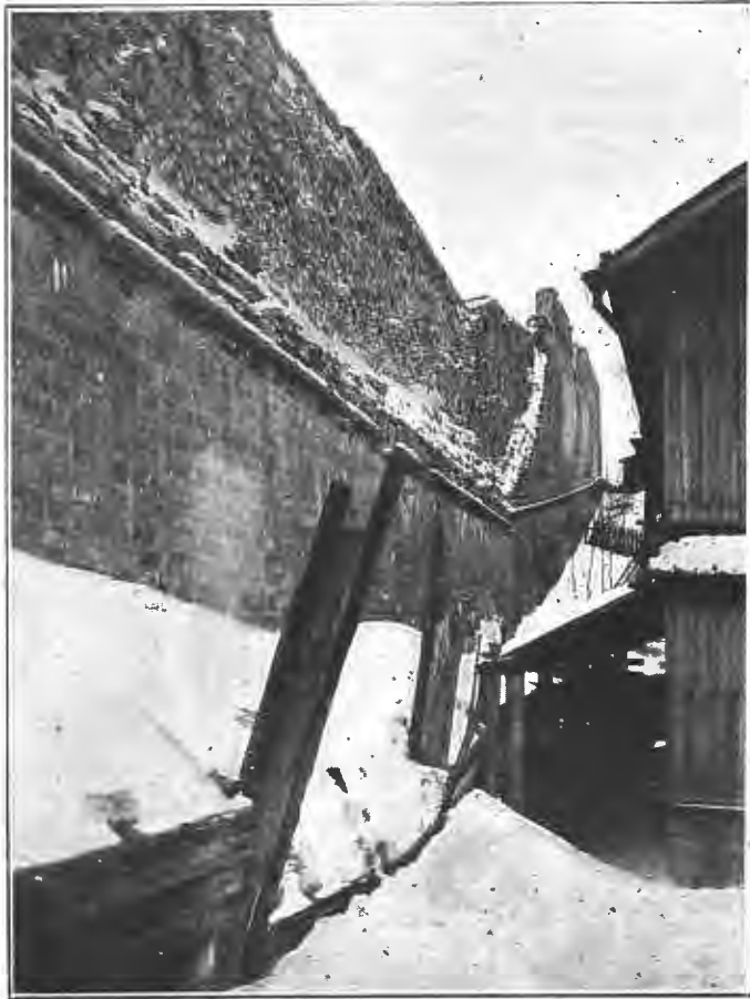
Смоленскія древности. Стѣна, разрушающаяся путемъ естественнаго отслаиванія. По фот. авт. «Нивы».
