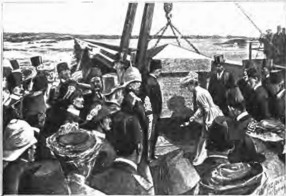
Ассуанская плотина на р. Нилѣ. Торжество открытія плотины. Герцогиня коннаутская укладываетъ послѣдній камень. По рис. Г. Беггъ, авт. «Нивы».
