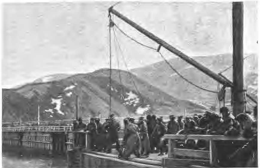
Работы по устройству набережной.
