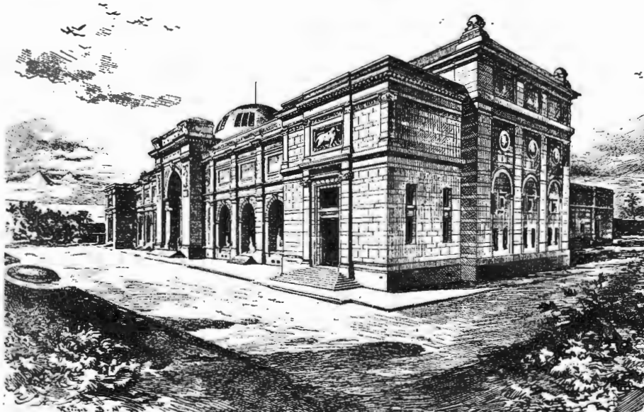
Музей египетских древностей в Каирѣ. Фасадъ здания со двора.
