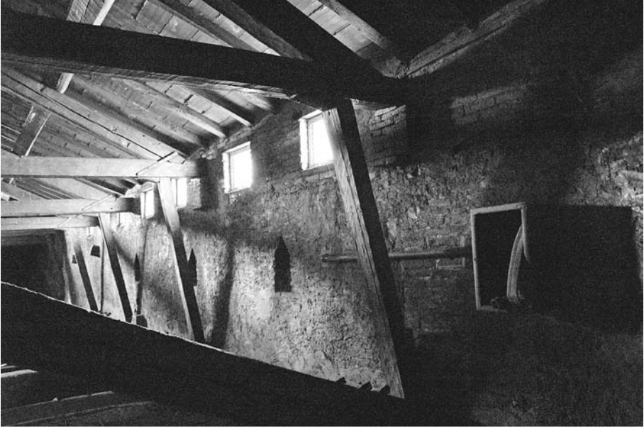
Fig. 6 – Sottotetto, il muro costruito da Bibiena sul fianco destro, verso il cortile interno, corrispondente al seg. BD del precedente grafico. Da notare la regolarità della struttura e la funzionalità di finestre e nicchie cuspidate per i lumi.
