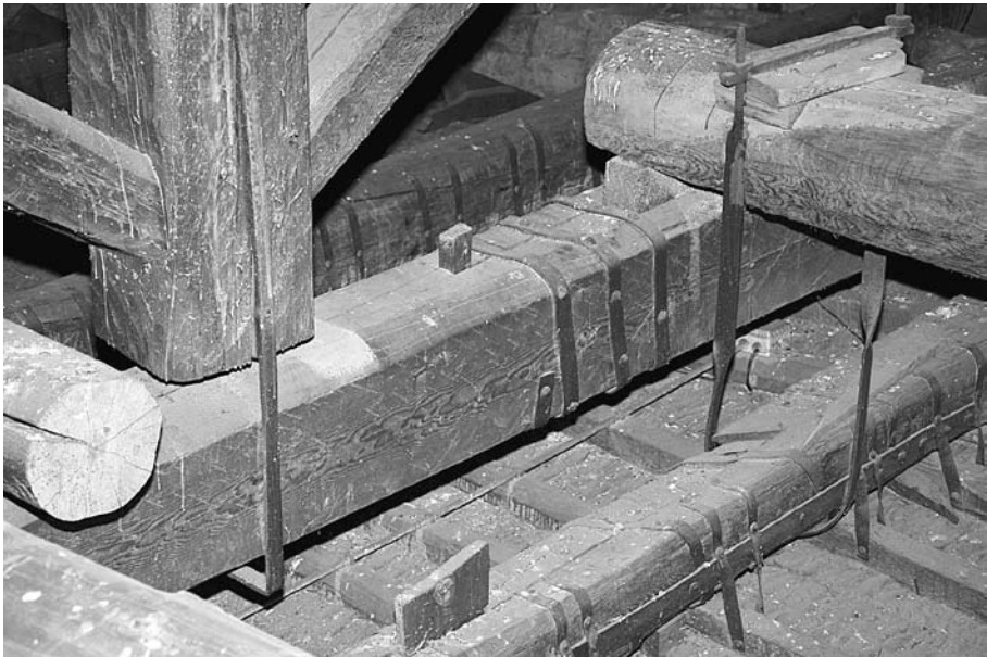
Figg. 8, 9 – Orditura lignea della copertura a falde, con un particolare che mostra giunti e fermenti.
