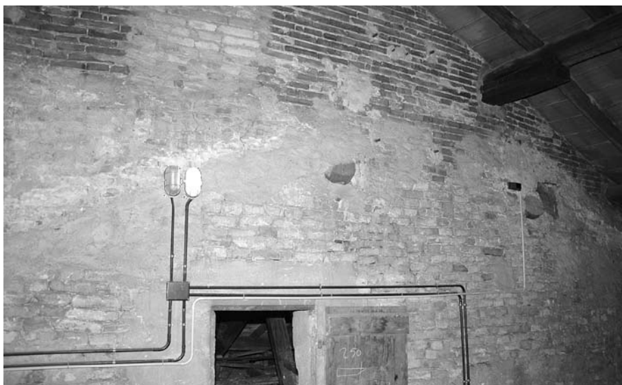
Fig. 11 – La parete, che separa la sala teatrale dal volume attiguo, prospiciente via dell'Accademia, mostra, nella fascia più chiara, l'andamento delle falde di copertura pertinenti al teatro cinquecentesco. Al di sotto si notano mattoni di grossa pezzatura, tipici del periodo; al di sopra si vedono le integrazioni in mattoni settecenteschi messe in opera da Bibiena per la sopraelevazione della copertura.
