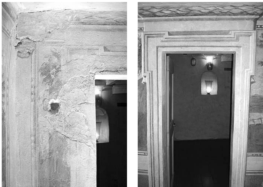
Figg. 17, 18 – Parete d'ingresso di un palchetto prima del restauro e dopo il restauro.
