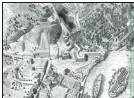
Pohled na opevnění Prahy v místech bývalé Újezdské brány – detail plánu Josefa Daniela Hubera z roku 1769
