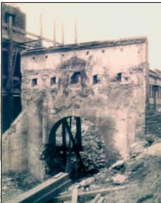
Zbytky Strahovské brány ze 14. století při bourání hradeb v roce 1898. Hradčanské hradby měly podobný charakter jako staroměstské opevnění, byly zpevněny hranolovými věžemi a procházelo jimi pět bran a branek, z nichž k nejvýznamnějším patřily brány Strahovská, Špitálská a sv. Benedikta
