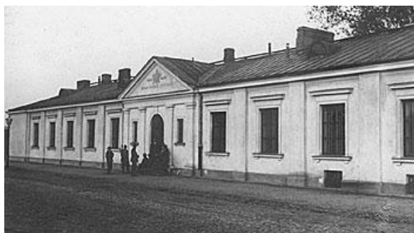
Fot. 2. Budynek koszarowy, widok z ok. 1925 Ze zbioru R. Marcinkowskiego.
