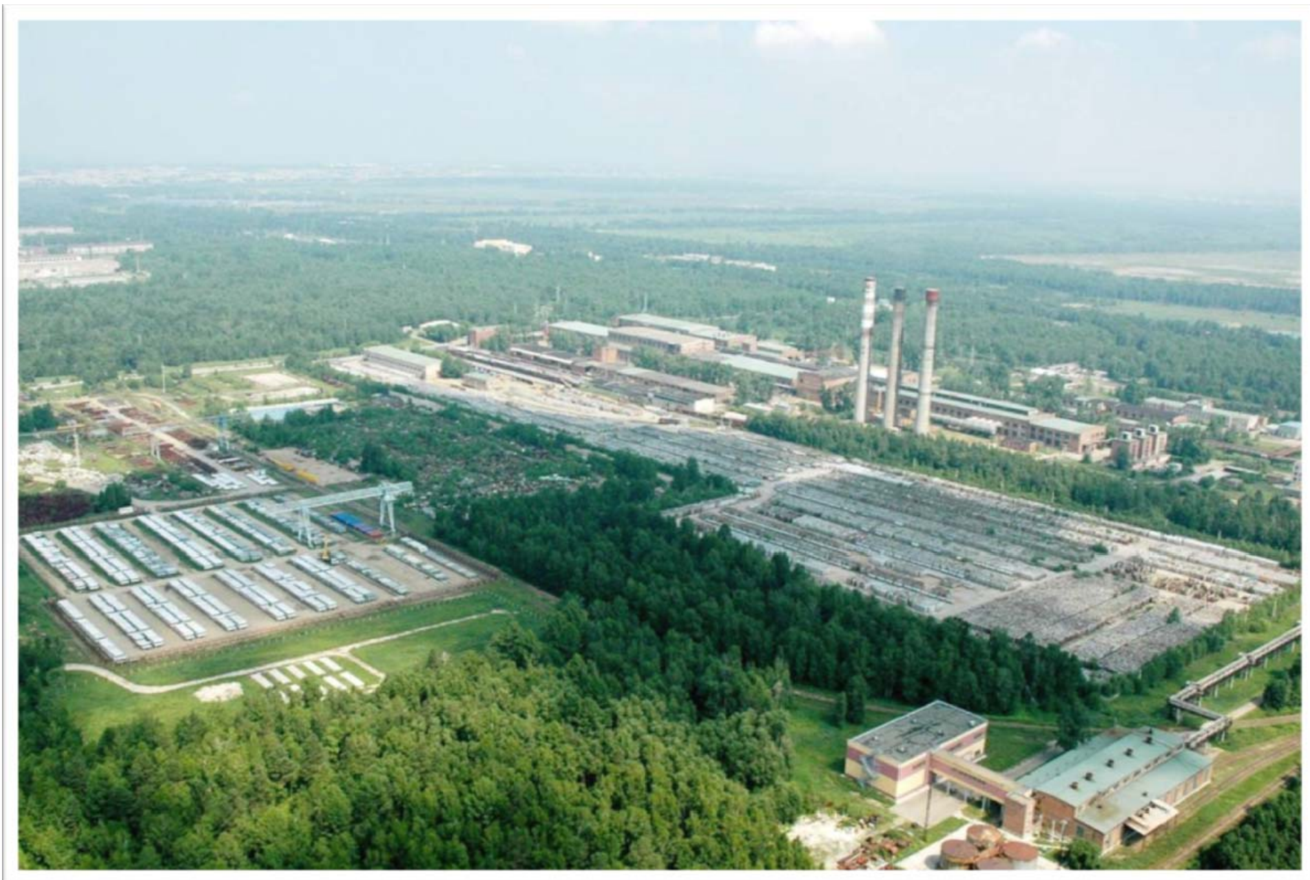
Склад контейнеров с ОГФУ на АЭХК (Россия)
