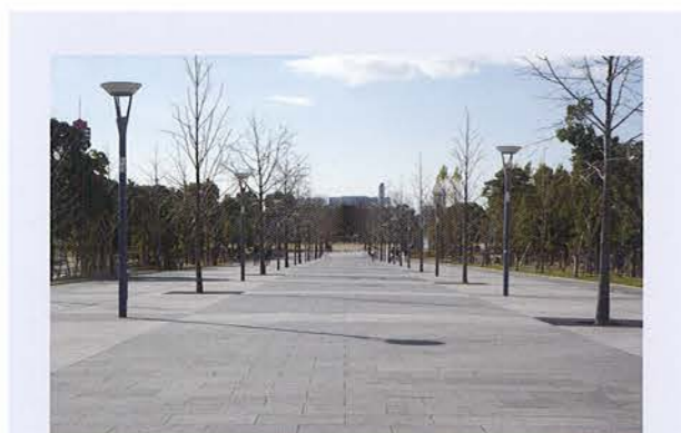
電柱のない美しい街並みは共同溝の存在により実現されています。
