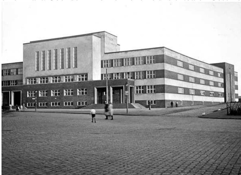
Das Lyzeum am Goetheplatz. Noch mit Flachdach (1932).
