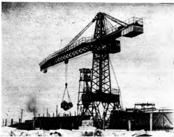
Кран БКСМ-14П на погрузке древесины в вагоны МПС (Комсомольский леспромхоз)
