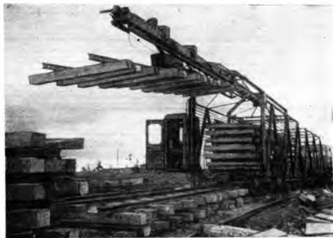
На строительстве лесовозной железной дороги в Оборском леспромхозе
