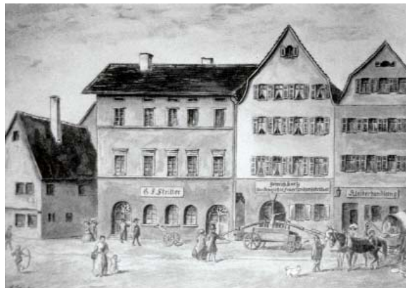
Bild 15: Das Haus von Johann Heinrich Kurtz (zweites von rechts) in der Hauptstätter Straße 38 (vormals 33) in Stuttgart
