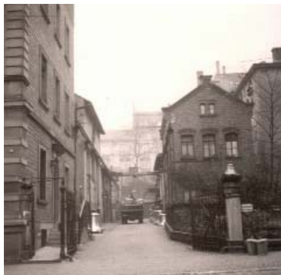
Bild 36: Einfahrt zur Glockengießerei in der Heusteigstraße 41
