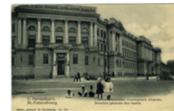
Здание Главного управления неокладных сборов (Тучкова набережная, д. 2-а), в котором с 1925 г. размещался Физиологический институт АН СССР.
