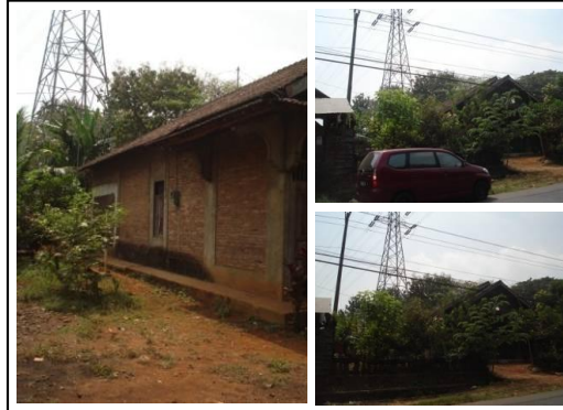
Permukiman di Bawah Jaringan SUTT Kecamatan Mlonggo
