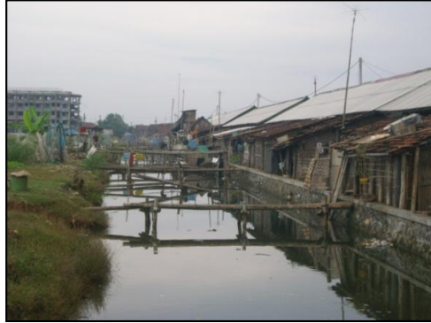
Permukiman di Sempadan Sungai
