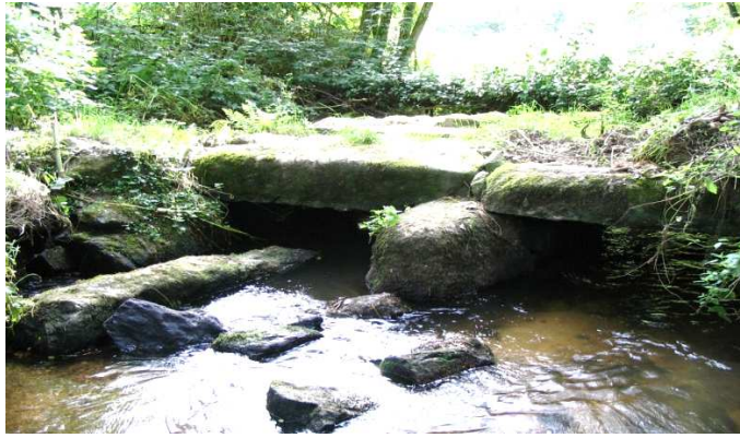
Fig. 20: Le pont de la Métairie
