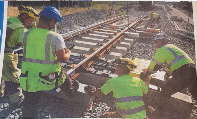
Vaihde asennetaan viiden metrin tarkkuudella. Kuvassa lähimpänä Lasse Jokinen, Tomi Jaakkola ja Pauli Seppänen. TAPPO/ILMARI
