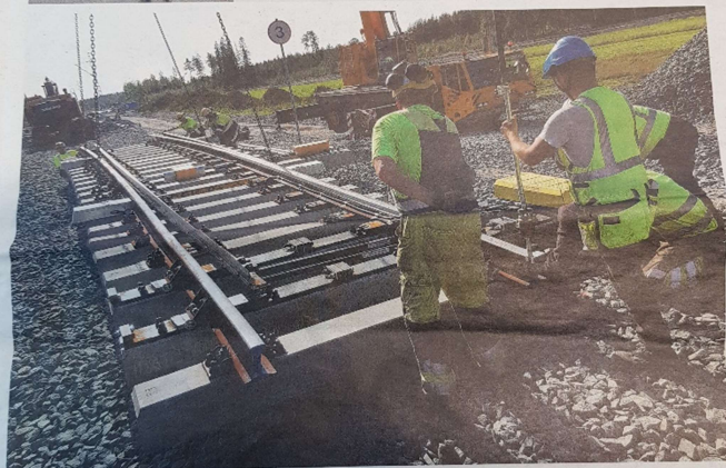
Vaihde-elementti asennettiin paikalleen Pännäisissä vilkkoheppänä. Tästä eteenpäin uutta rataa syntyy vihreää vaubtia. TAPPO/ILMARI
