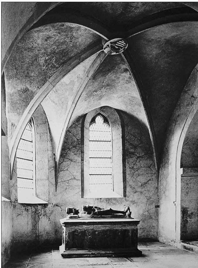
Abb. 6: Die Grabkapelle. Aufnahme von 1993. Der veränderte Fugenverlauf im Sandsteinboden im Vergleich zur Aufnahme von 1960 verdeutlicht dessen Umgestaltung. Die Marmorierung der Wände (von 1975) ist der barocken Raumfarbigkeit nachempfunden.
