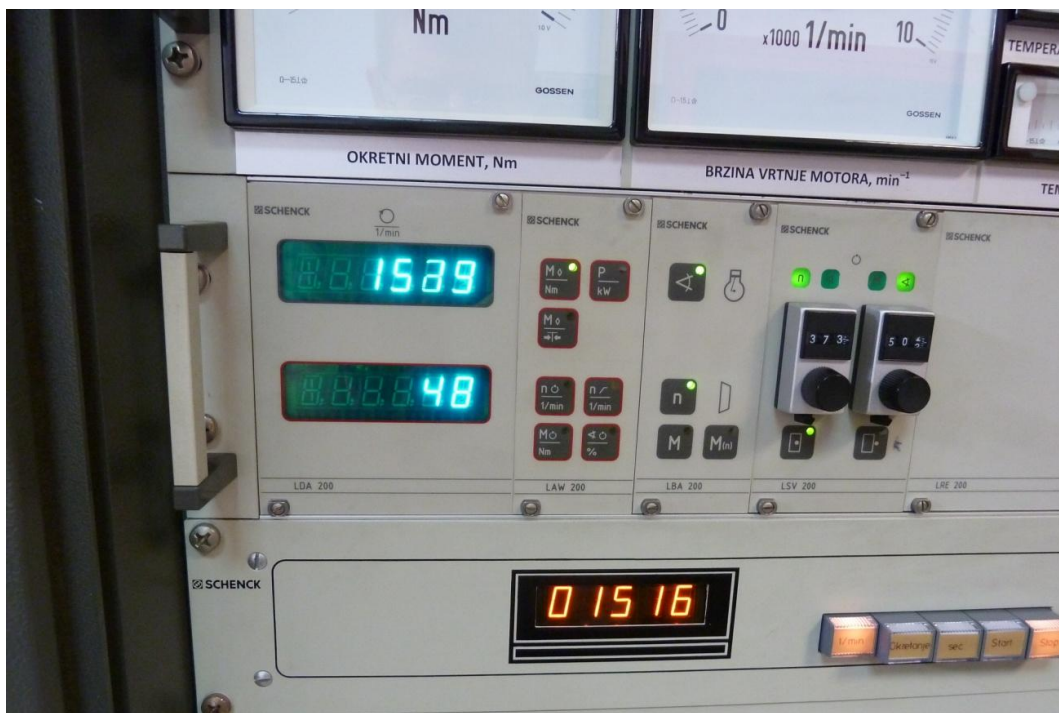
Slika 9.13. Fotografija ispitnog ormara s kojeg se očitava brzina vrtnje kočnice
