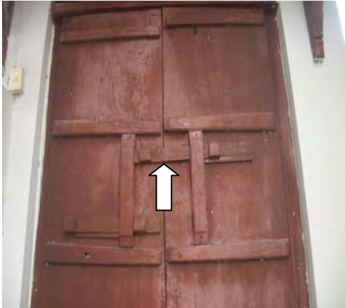
ภาพที่ 6.12 ตัวอย่างหูช้างของประตู (ตรงลูกศรสีขาวที่อยู่ตอนกลางประตู)
