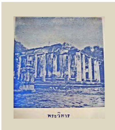
ภาพที่ 11.25 พระวิหาร วัดหงส์รัตนารามในอดีต
