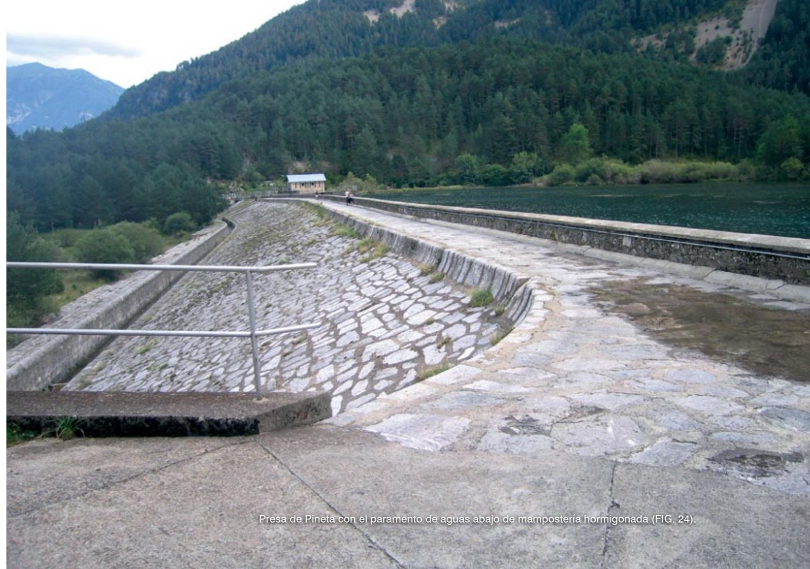
Presa de Pineta con el paramento de aguas abajo de mampostería hormigonada (FIG. 24).
