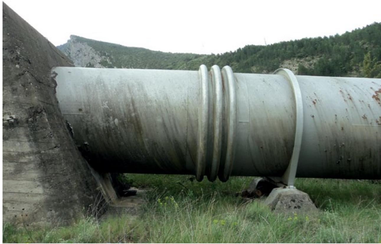
Junta de dilatación de onda en la tubería de la central de Argoné (FIG. 29).
