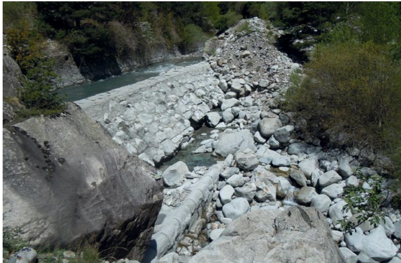
Azud de desvío del río Barrosa para canalizarlo a la cámara de carga del canal de Bielsa (FIG. 18).
