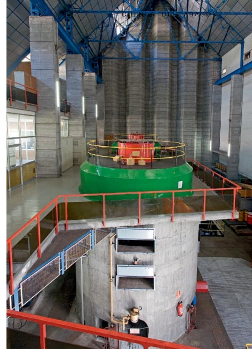
Interior de la central de Ip. Las turbinas quedan por debajo de la solera de la nave (FIG. 10).
