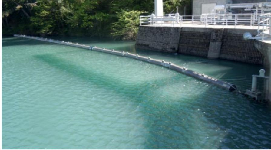
Presa de Laspuña cuya toma requiere tener las compuertas cerradas. Puede verse el flotador para desvío de flotantes (FIG. 13).
