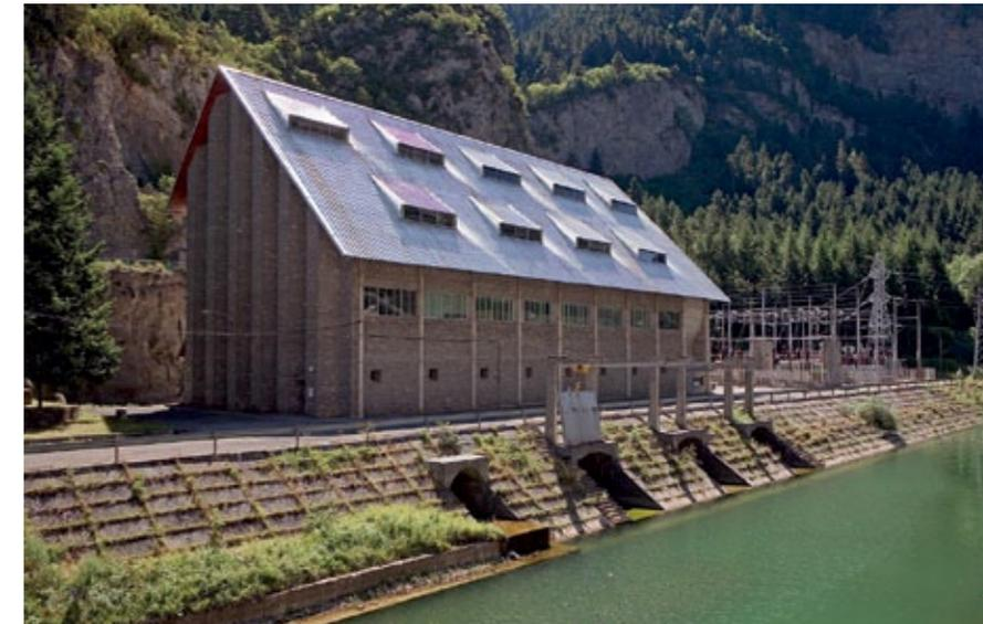
Central de Ip y embalse de Canfranc en el que se vierte al turbinar y desde el que se aspira para bombear. Puede verse que el nivel del agua está por debajo de la cota de la solera de la central (FIG. 13).
