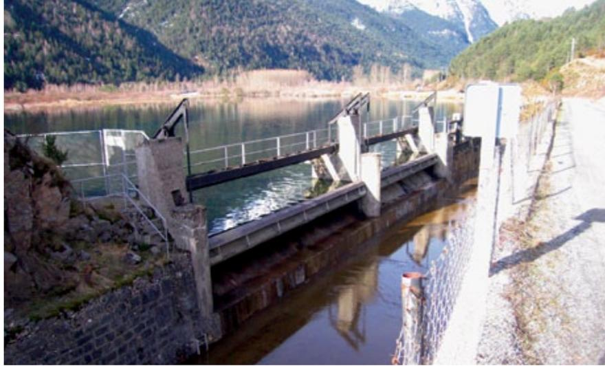
Clapetas abatibles y compuertas verticales de la presa de Pineta (FIG. 22).
