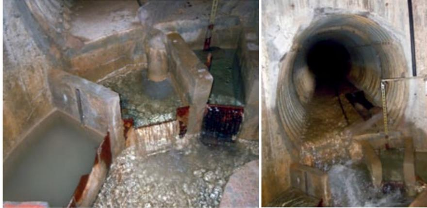
Filtraciones en la galería con el embalse en la cota +2.102. El piso de la galería está seco (FIG. 06).
