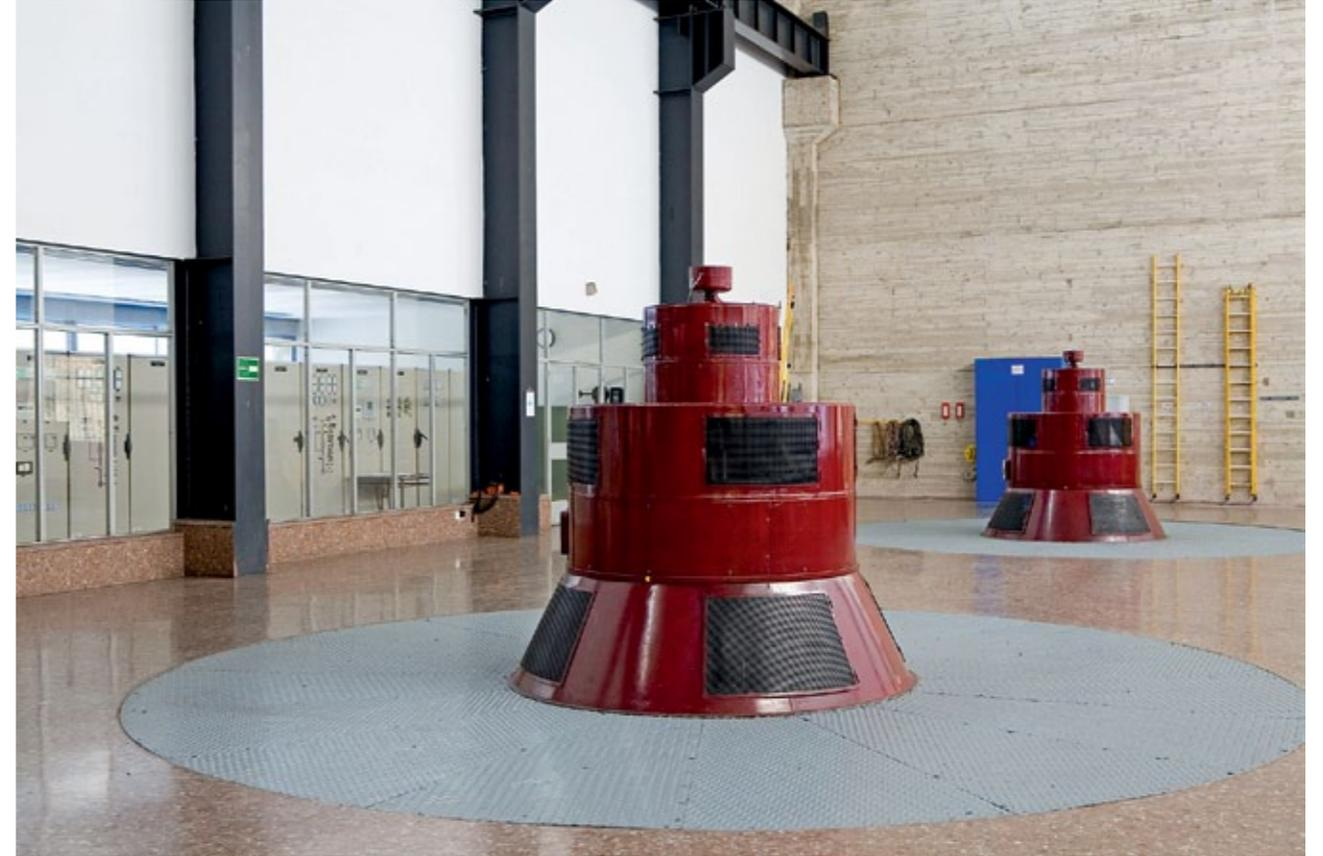
Interior de la central de Lanuza con los dos alternadores sobre las turbinas Francis de eje vertical (FIG. 65).
