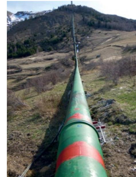
Tubería de la central. Pueden verse varios machones de anclaje y la chimenea de equilibrio (FIG. 52).
