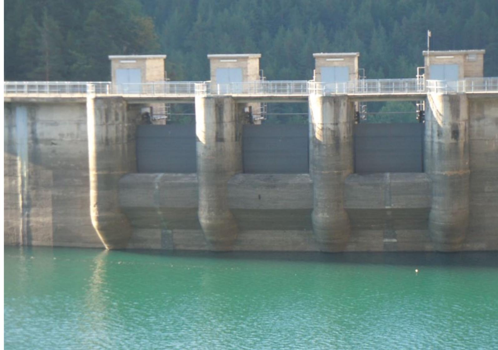
Se suele decir que no es probable que ninguna de estas presas se caiga, pero sí es posible que en una avenida haya un funcionamiento deficiente que provoque caudales superiores a los incidentes en el embalse y cause daños achacables a una mala explotación. Como la presa de Paso Nuevo tiene compuertas (FIG. 14), a continuación detallamos el sistema que se sigue en Acciona. En Paso Nuevo las compuertas son de tipo Taintor.
