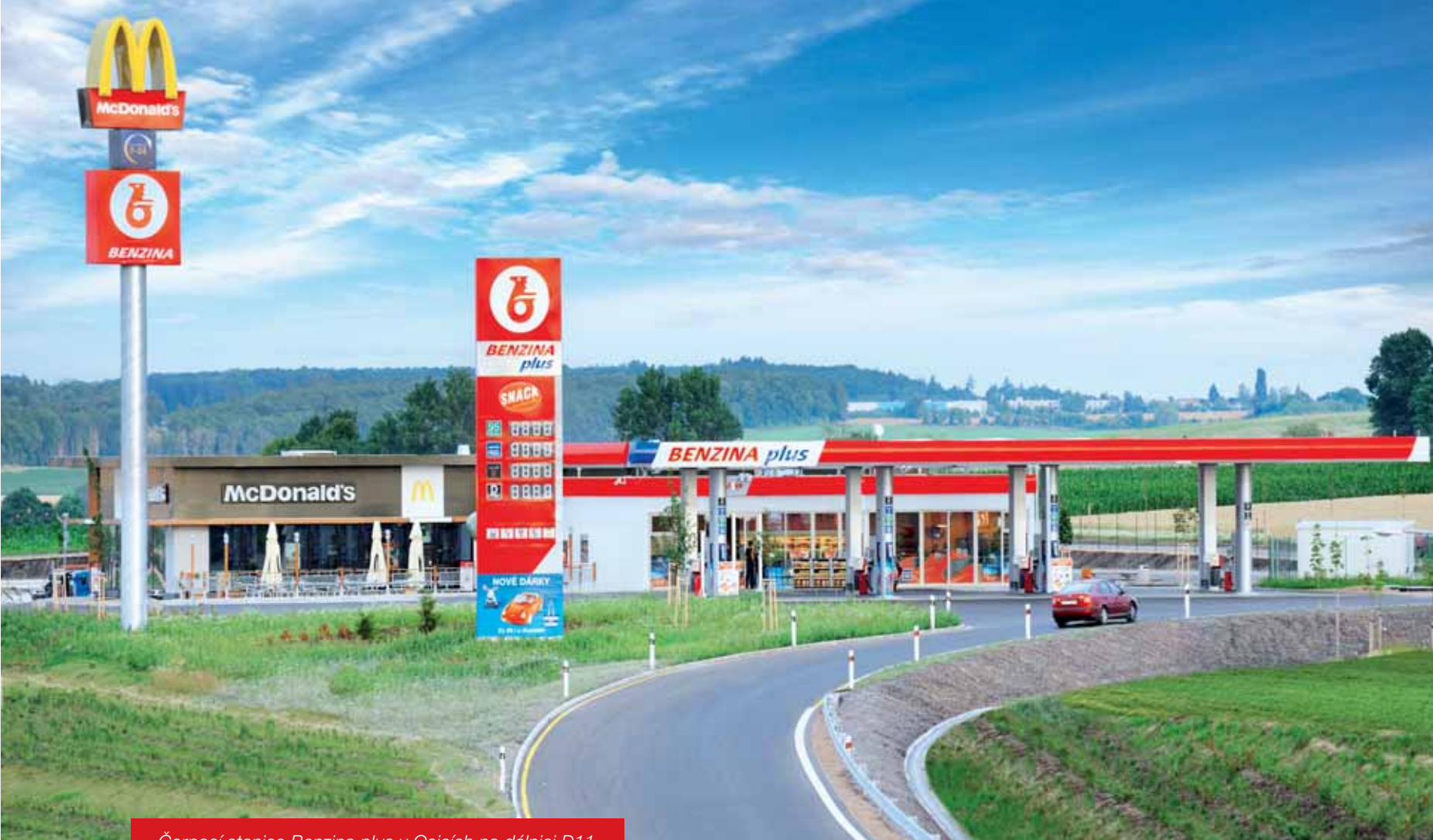
Čerpací stanice Benzina plus v Osicích na dálnici D11.
