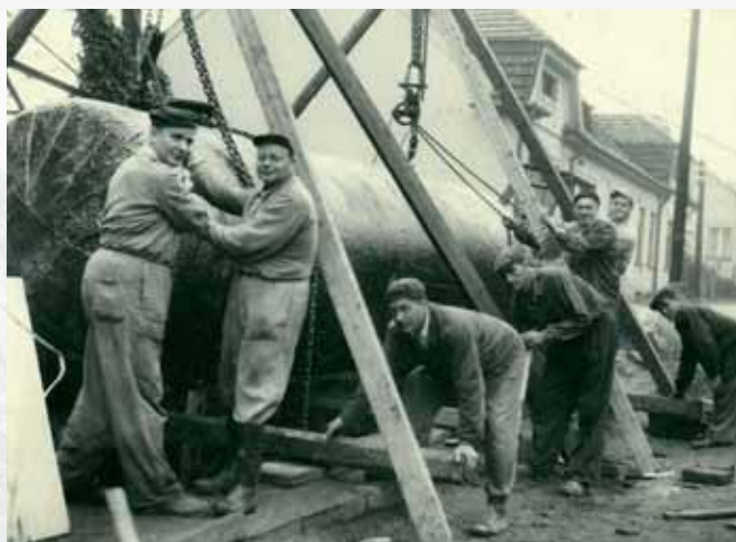
Budování čerpací stanice v Černé Hoře (60. léta).
