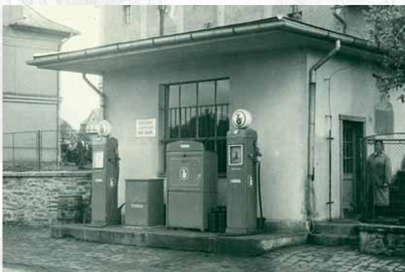
Čerpací stanice v Horšovském Týně.
