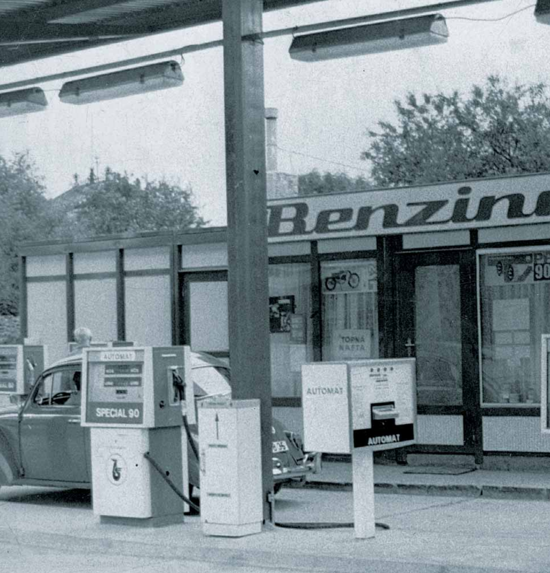
Počátkem sedmdesátých let byly u některých čerpacích stanic instalovány automaty na dvacetikorunovou bankovku. První zahájil provoz v Karlíně v roce 1972, kde nahradil noční směnu. Všechny tyto přístroje byly však zanedlouho staženy z provozu. Snímek zachycuje automat na Královopolské ulici v Brně.
