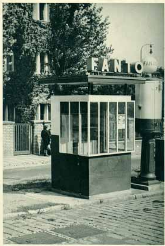
Kiosek pro obsluhu čerpadla (30. léta).
