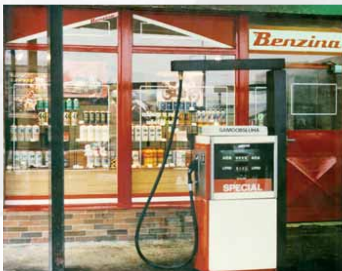
Typická podoba čerpačí stanice Benziny v 80. letech.
