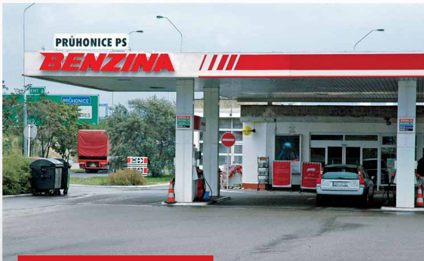
Exteriér čerpačí stanice v Průhonících před rekonstrukcí...
