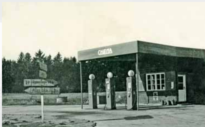
Čerpací stanice v Kolečově.
