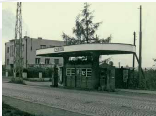
Čerpací stanice na Nepomucké ulici v Plzni.
