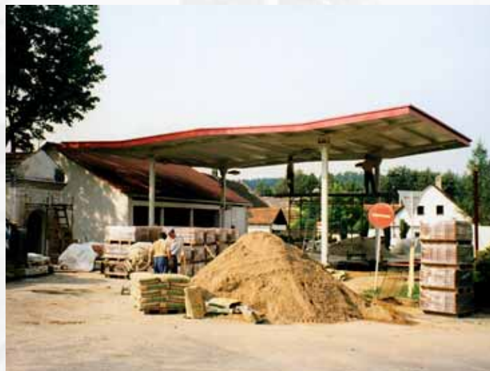
Rekonstrukce čerpací stanice ve Zruč nad Sázavou.
