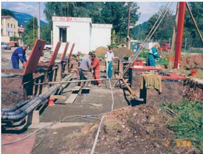
Ukázka výstavby nového potrubního systému na čerpací stanici v Dobřanech (90. léta).
