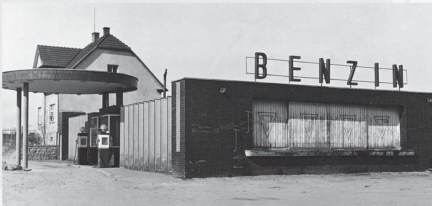
Čerpací stanice společnosti Fanto ve Zlíně-Prštném (1936).
