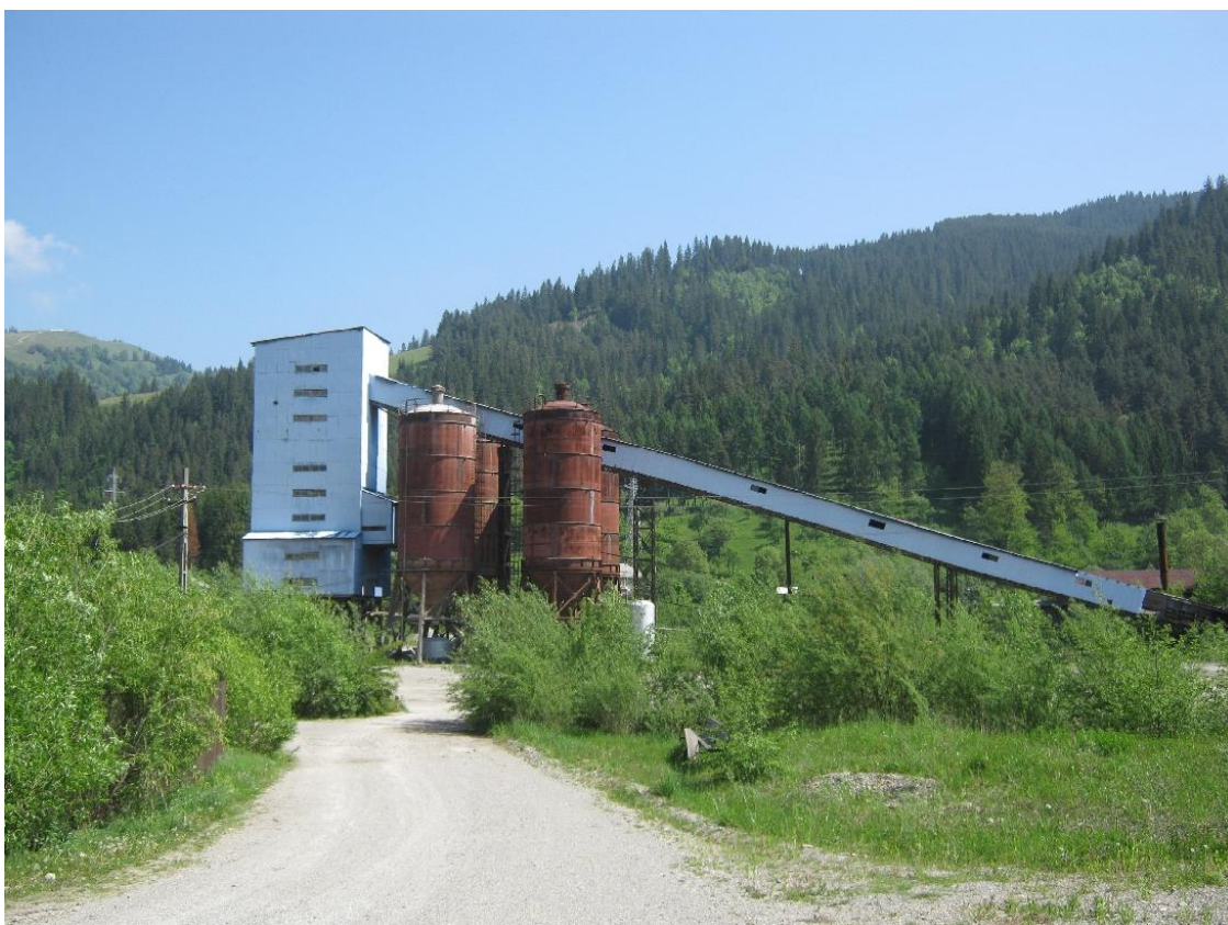
Figura 5 Fabrica de betoane HIDROCONSTRUCȚIA S.A. Poiana Teiului
