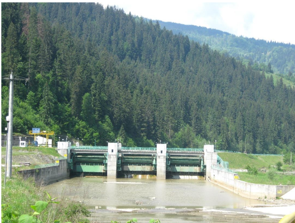
Figura 2 Baraj Lac de acumulare Topoliceeni
