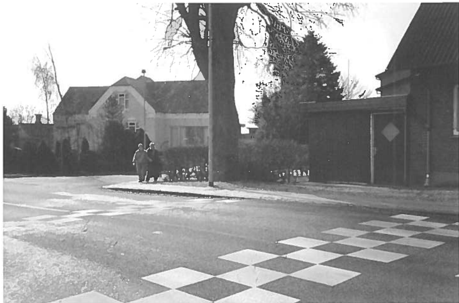
Ud over sit oprindelige formål, at dæmpe bilernes hastighed, tjener bumpene her desuden som kørestolsbrugeres mulighed for færden fortov/fortov og kørebane/fortov.
