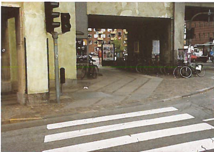
Ved Nørrebro station blev flisebelægningen ændret. Der blev opsat cykelstativer for at friholde ganglinien. Ved fodgængerfeltet blev kantstenen sænket, og der blev etableret akustisk signal for de blinde.
