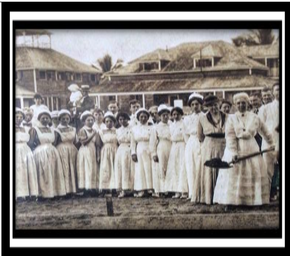
Figura 237. Mujeres colocando la primera piedra del Hospital Presbiteriano (Sepúlveda, 2015).
