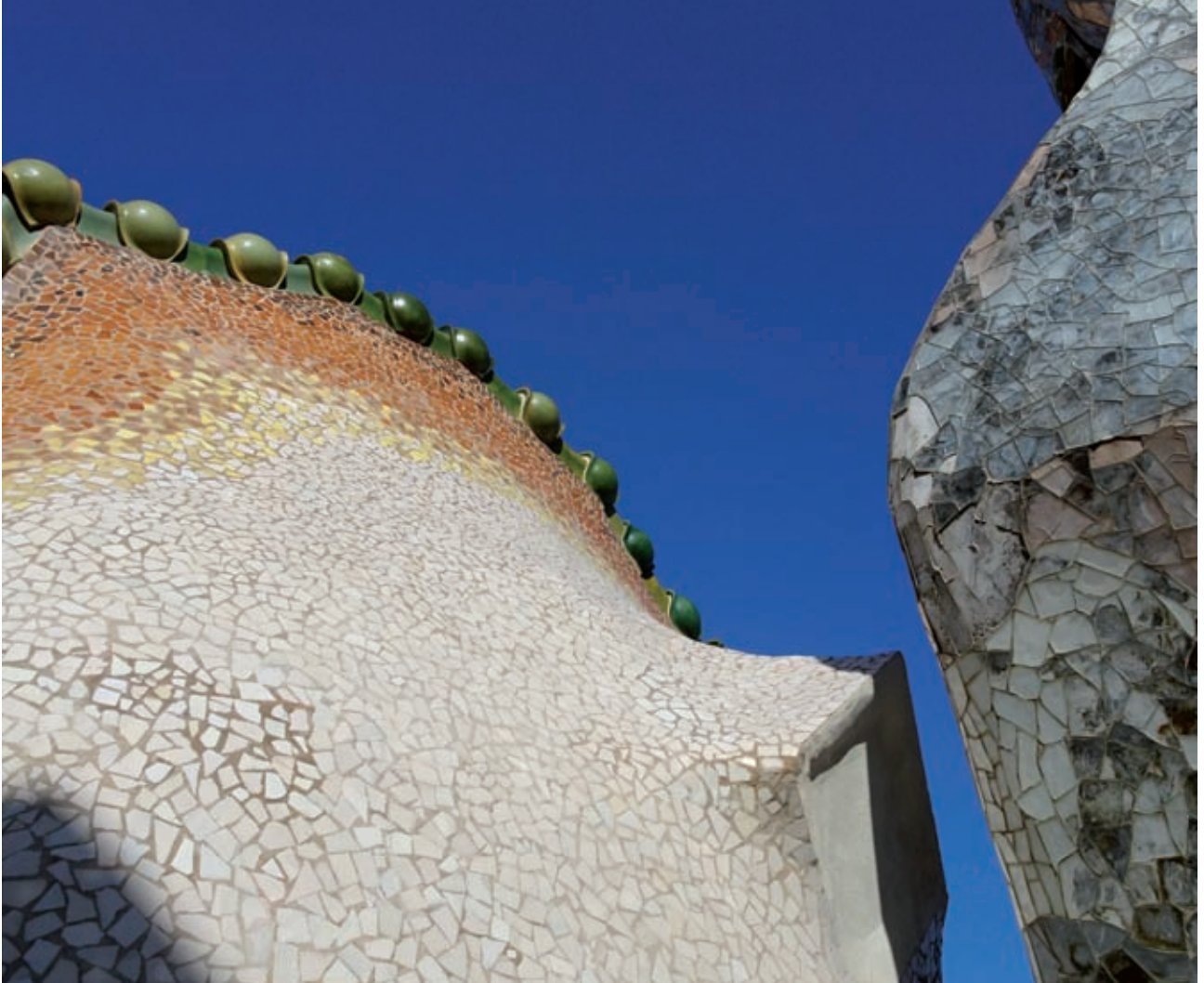
Restauración de la Casa Batlló.
