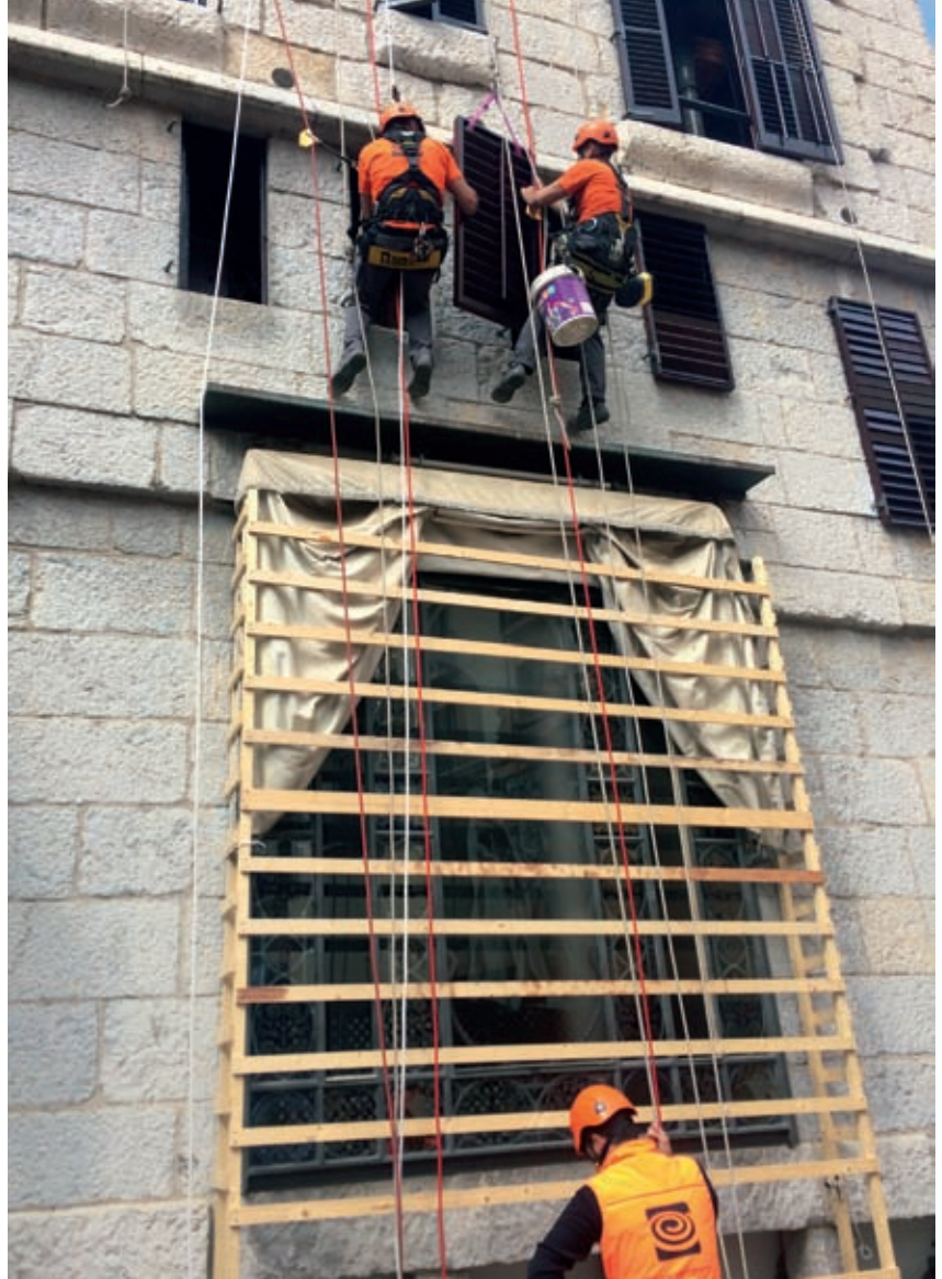
Trabajos de rehabilitación en el exterior. Archivo SPAL
