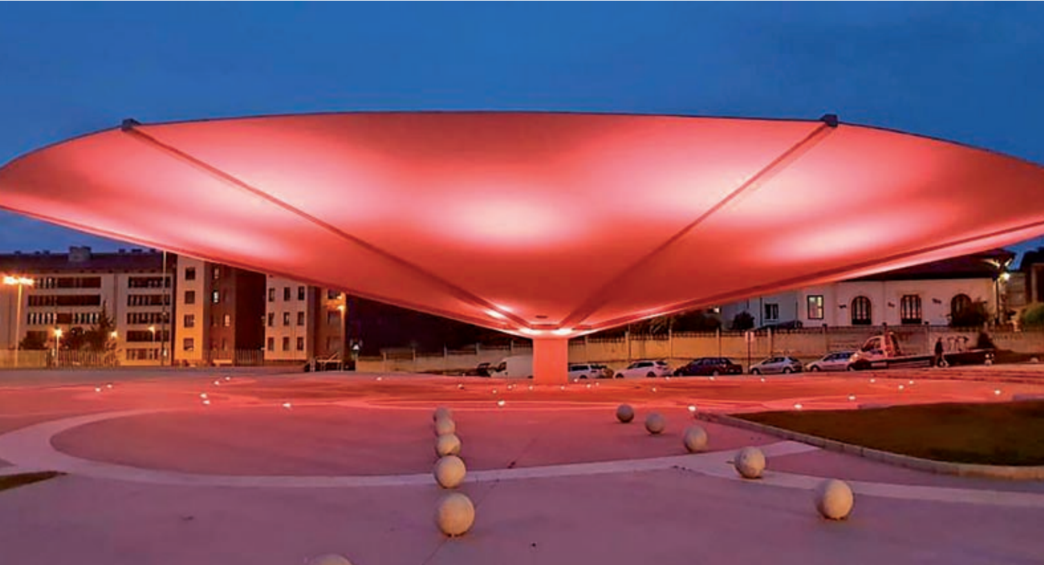
Paraguas de hormigón del antiguo mercado de ganado de Pola de Siero.
