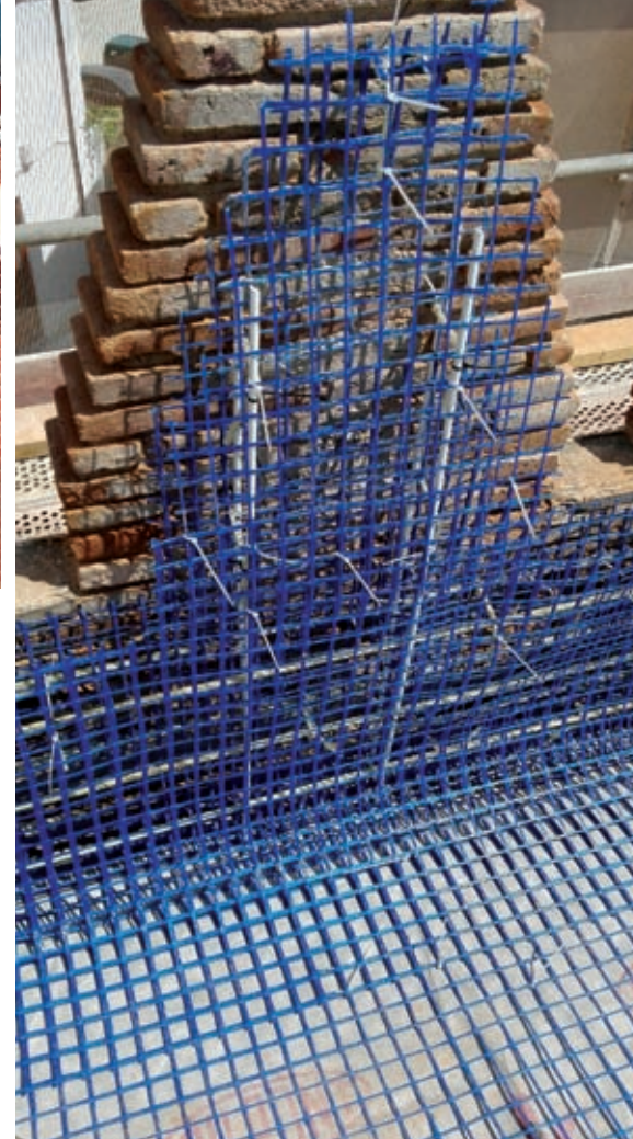
Fotos del equipo técnico al completo, detalle de la fachada y del refuerzo realizado en las almenas.
