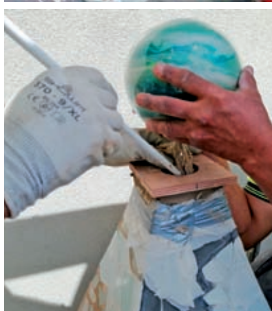
Bolas de cristal de las chimeneas, fijadas con MAPEWRAP G FIOCCO, rellenas con MAPE-ANTIQUÉ I y arenas de colores
