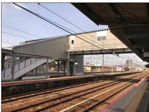
新こ線橋全景
