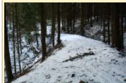
Náspe pomocné drážky od Nové Vsi v lese vysoko nad pravým břehem Haldy.
