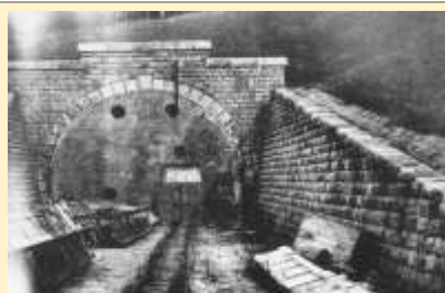
Zazděný západní portál loučského tunelu (217A) se vstupními vraty a zásobovací úzkokolejnou tratí (uprostřed). Archív MZK Brno.
