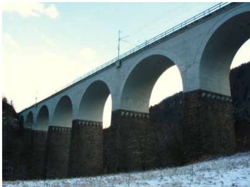
Vlevo: železniční viadukt v Mezihoří. Délka 180m max. výška 38m, betonové pilíře obkládané bosovaným kamenem, horní část železobeton. Obrázek nahoře: Zbytky základů vrátku na terase v úrovni tišnovského portálu tunelu, asi 30m jižně od něj (č.4 na mapce)
