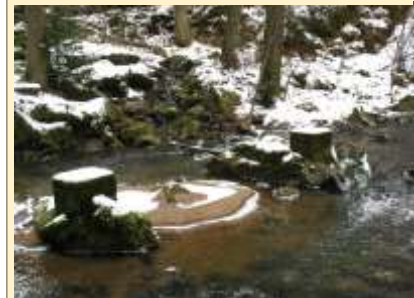
Betonové opěry posledního z přemostění Haldy u Pochopovy skály (pod tunelem B).
