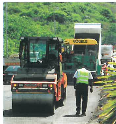
Așternerea și compactarea mixturii reci din materiale reciclate
