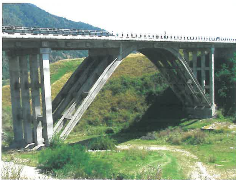
Fig. 3. D.N. 66 (Petroșani - Deva), km 172 + 330, Viaductul Ohaba de sub Piatră. În desen, faza de montaj a arcelor
