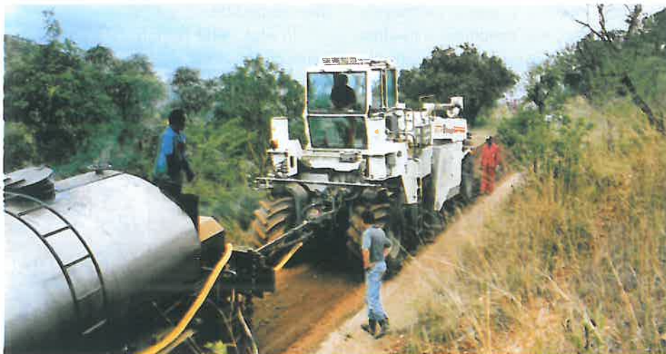
Prelucrarea unui drum de piatră. Reabilitarea se face printr-o trecere prin adaos de bitum spumat
