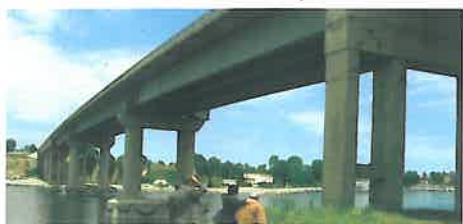
Fig. 23. D.N. 39 (Constanța - Vama Veche), pod peste lacul Mangalia, la Mangalia. Podul în exploatare
