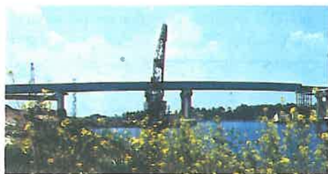
Fig. 22. D.N. 39 (Constanța - Vama Veche), pod peste lacul Mangalia, la Mangalia. Faza de lansare, etapa a II-a
