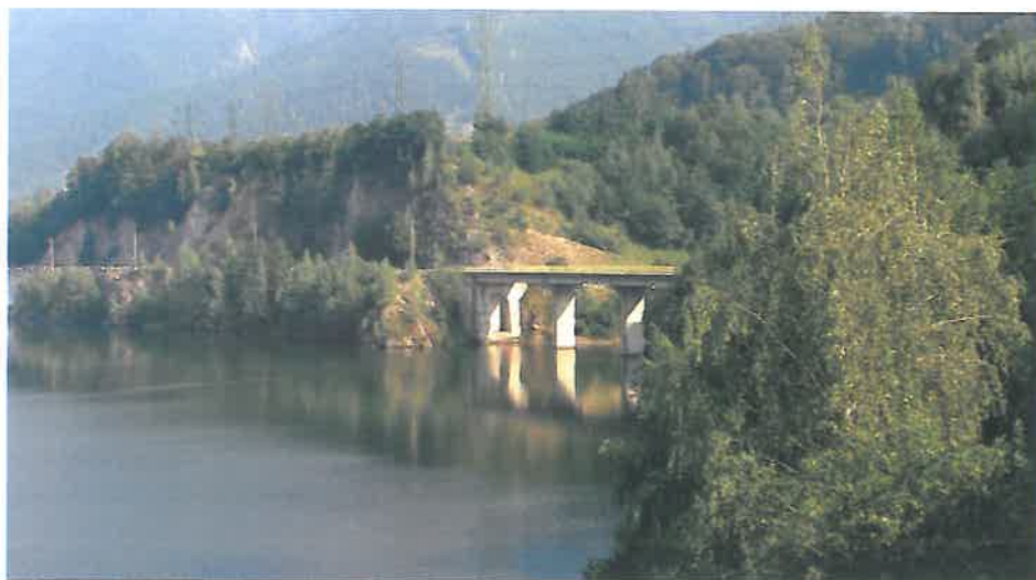
Fig. 12. D.N. 7A (Brezoi - Voineasa), km 25 + 417, Viaductul Bucureasa
