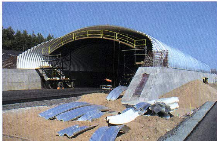
Fig. 6 Execuție sub circulație a podurilor SuperCor
