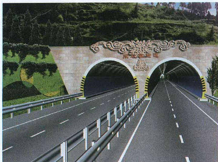
Fig. 5 Tunel în Jicheng, provincia Shanxi
