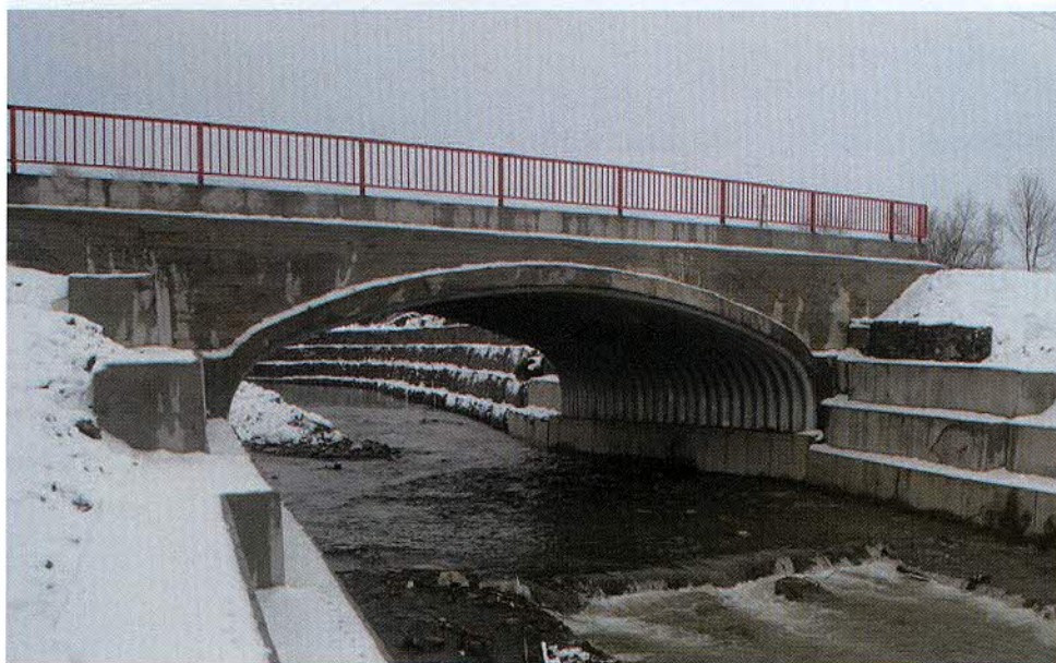
Fig. 4 Vedere din aval pod peste valea Chechișelului
