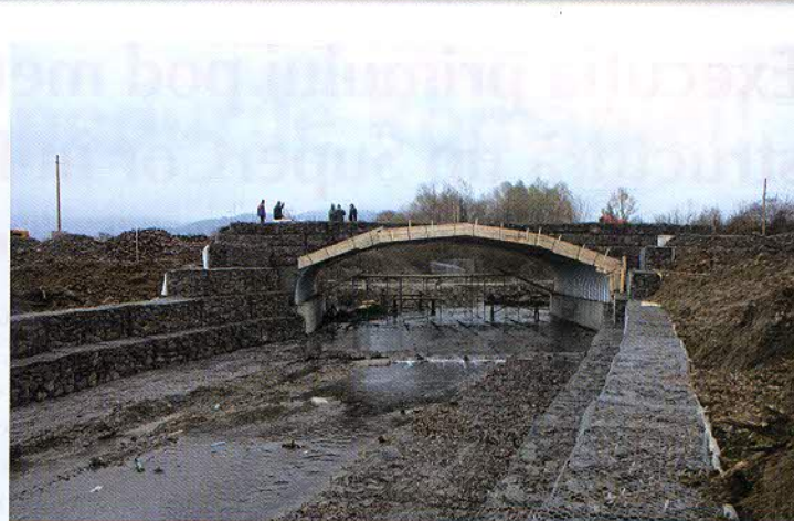
Fig. 3 Execuția timpanelor din gabioane, gulerelor din beton armat și apărărilor de maluri
