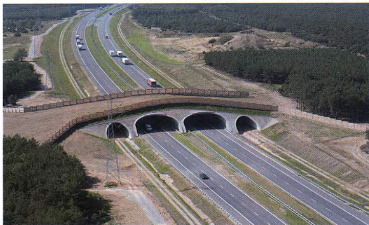
Fig. 5 Pod-pasaj pentru animale din structuri SuperCor pe autostradă în Polonia
