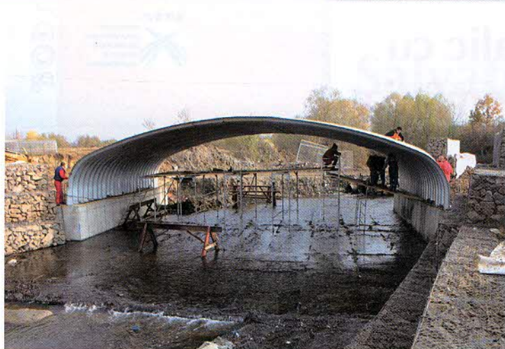
Fig. 2 Structura metalică montată
