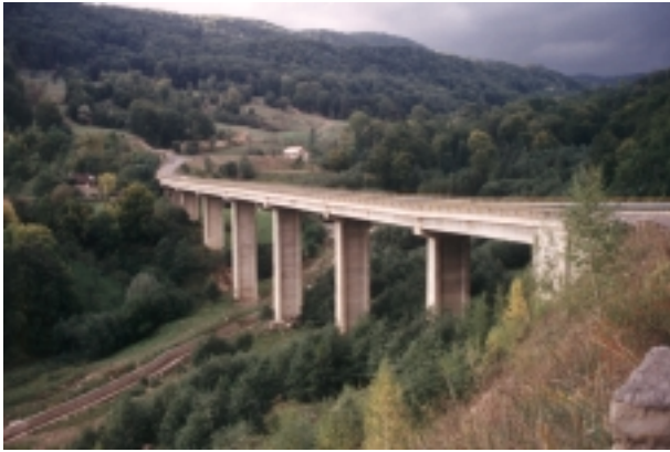
Fig.4.11. DN10 - Viaductul Siriu
