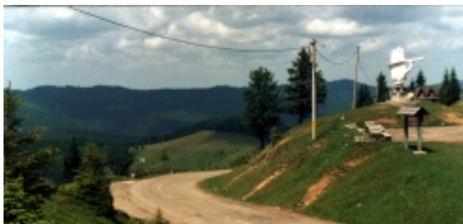
Fig. 4.1. DN 17A - Sadova-Rădăuți Monumentul Drumarilor
