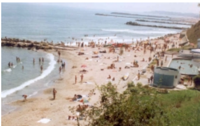
Fig. 5.1. Lucrări pentru formarea și protecția plajelor - Eforie Nord -
