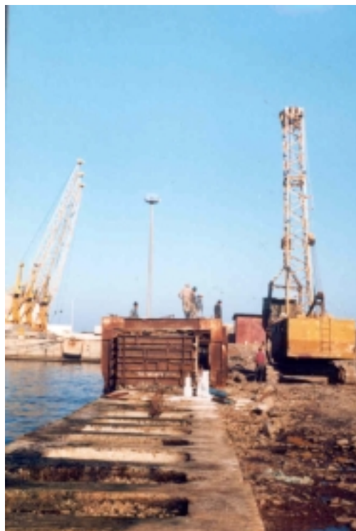
Fig.5.3. Execuție cheu la -7,00 Port Nador - Maroc
