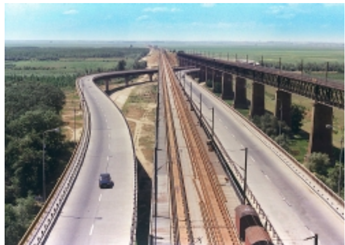
Fig.4.13. Viaductele podului peste Dunăre la Cernavodă
