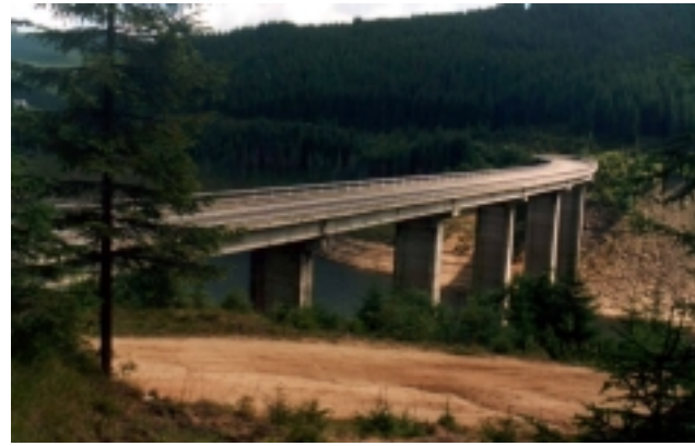
Fig.4.12. DN67C - Viaductul Oașa
