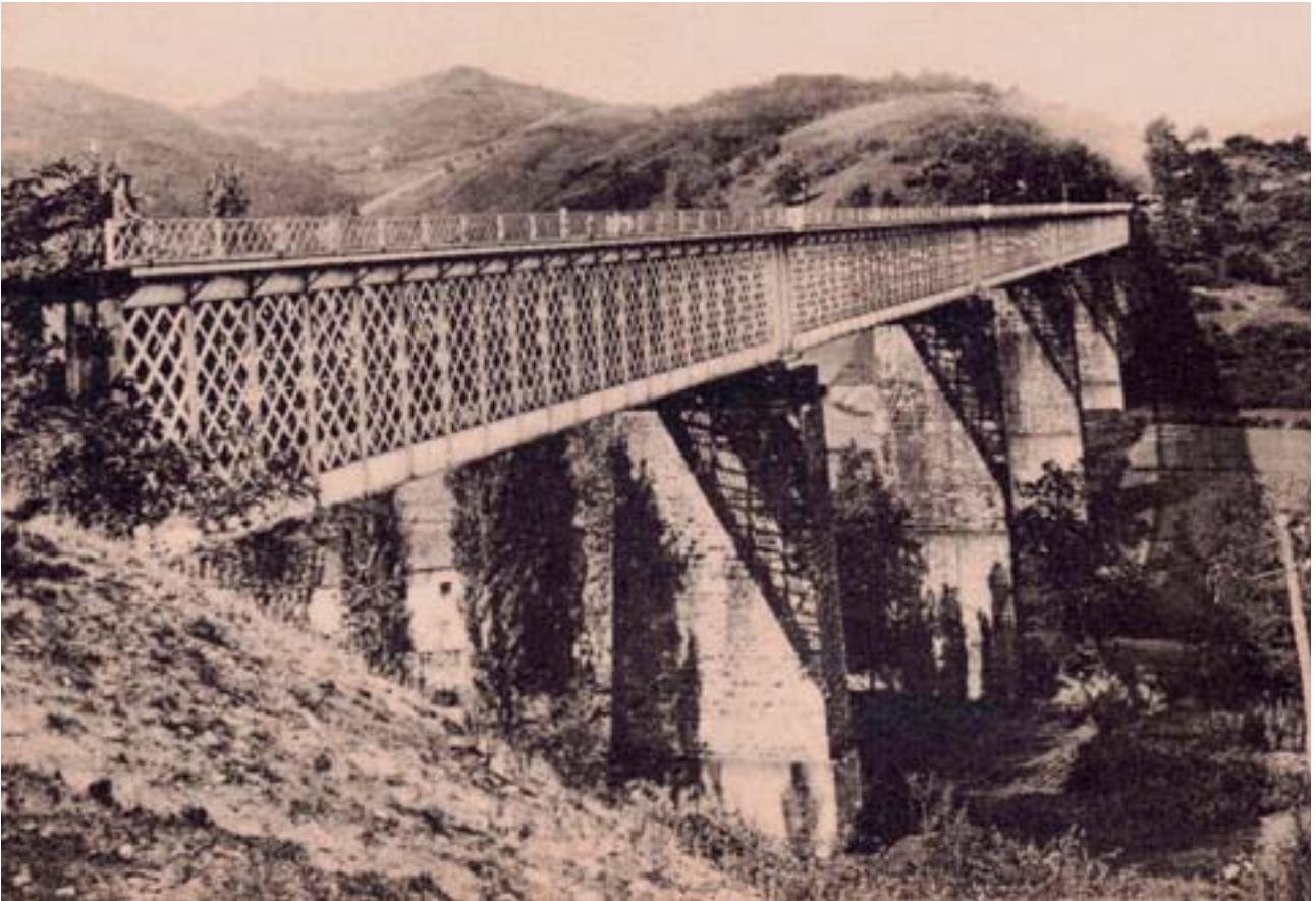
46 Zubia, línea elektrifikatu aurretik Viaducto antes de la electrificación de la línea
