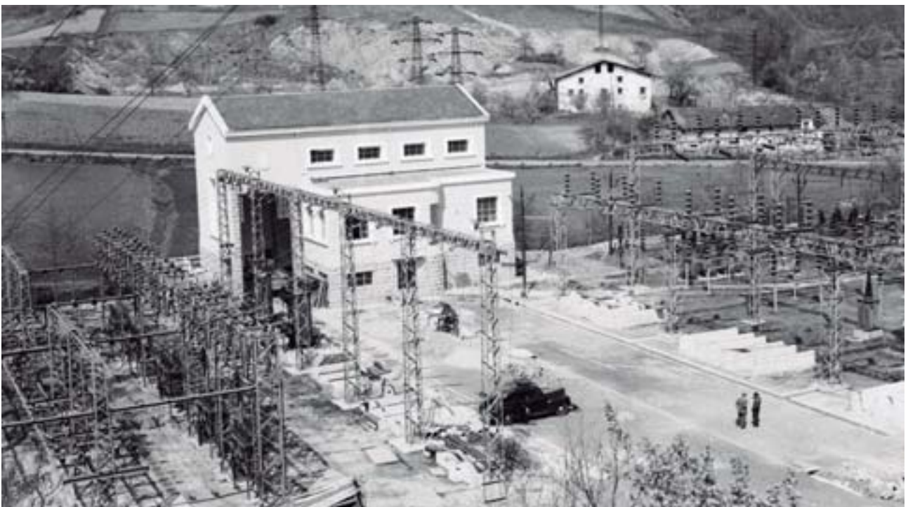
102 Muntaketa eta kontrolerako eraikina eta Ormaiztegi azpi-estazioaren lanak Edificio de montaje y control y obras de la subestación de Ormaiztegi
