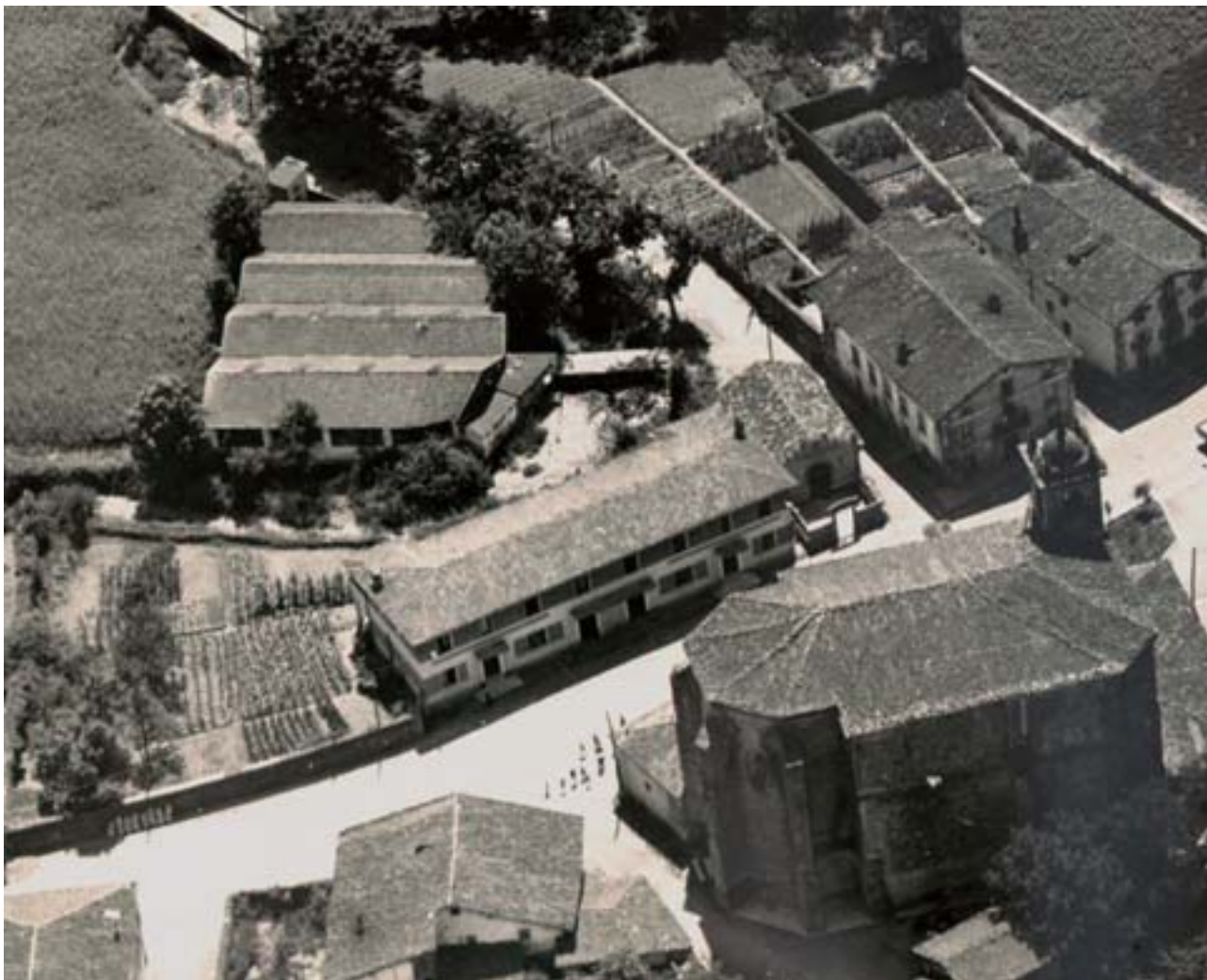
156 1942ko sutearen ondoren eraikitako pabiloiak Nuevos pabellones construidos tras el incendio de 1942
