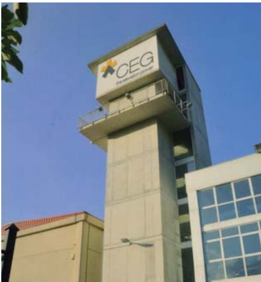
229 Entsegu dorrea Torre de ensayos
