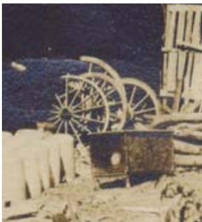
335 Urbieta Bigarrena eta gurpilen xehetasuna Urbieta Bigarrena y detalle de ruedas
