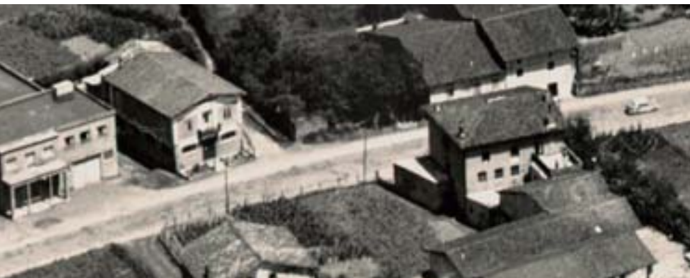
170 1952an eraikitako pabiloiak, Zumarralde kalean Pabellones construidos en 1952, en Zumarralde kalea
