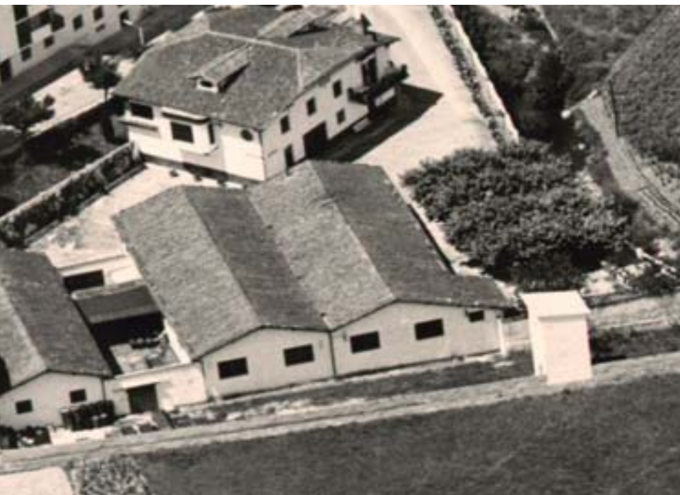
304 Garcíaren pabilioiak eta txaletak Pabellones de García y chalés
