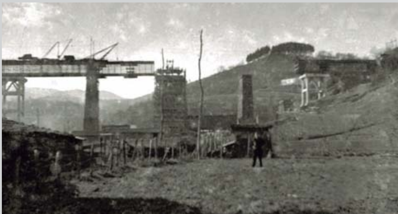
74 Zubia berreraikitzeo lanak Obras de reconstrucción del viaducto
