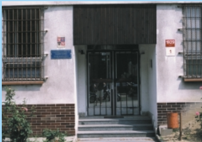
Vazební věznice České Budějovice
