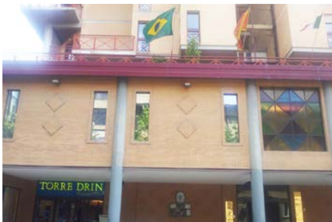
Edifício em que se localiza a Embaixada do Brasil em Tirana (Albânia).
