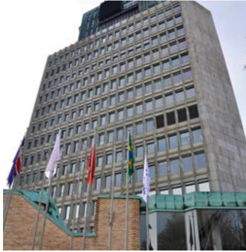
Edifício em que se localiza a Embaixada do Brasil em Liubliana (Eslovênia). Foto cedida pelo posto.
