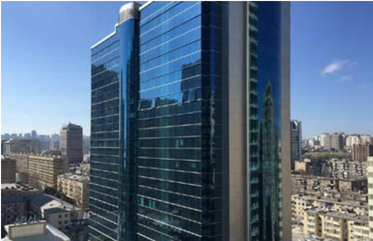
Edifício em que se localiza a Embaixada do Brasil em Baku (Azerbaijão).
