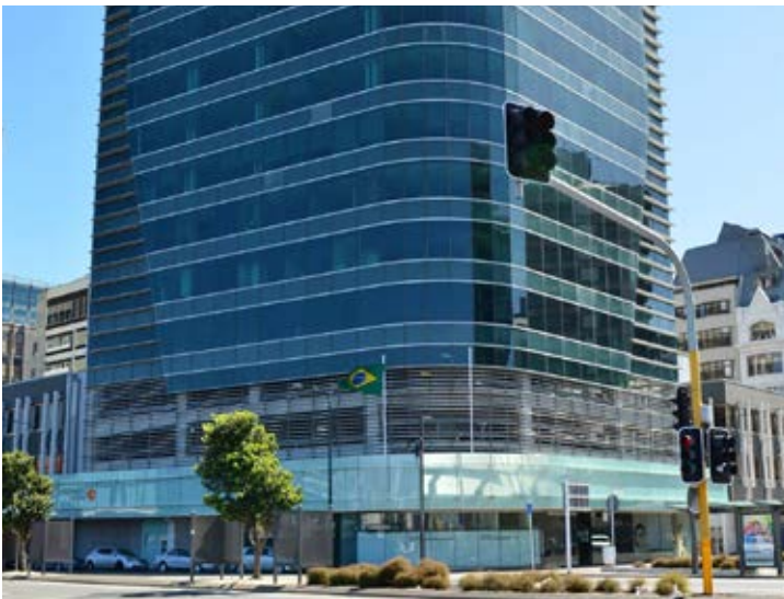
Edifício em que se localiza a Embaixada do Brasil em Wellington (Nova Zelândia). Foto da página de Facebook do posto.
