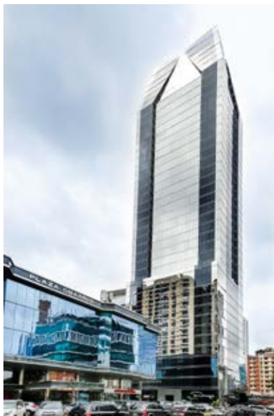
Edifício em que se localiza a Embaixada do Brasil na Cidade do Panamá (Panamá). Foto cedida pelo posto.
