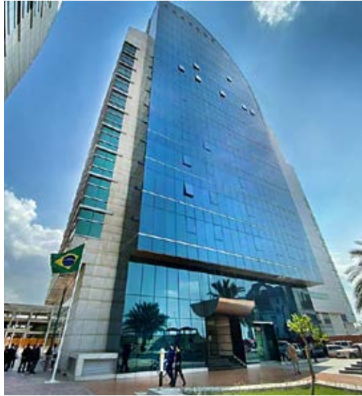
Edifício em que se localiza a Embaixada do Brasil em Abu Dhabi (Emirados Árabes Unidos). Foto da página de Facebook do posto.
