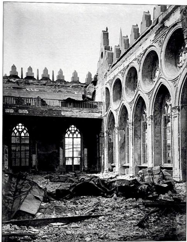
Bakı şəhərində Nikolayevskaya küçəsində "İsmailiyyə" Müsəlman Xeyriyyə Cəmiyyətinin binasının yanğından sonra daxili görünüşü.
