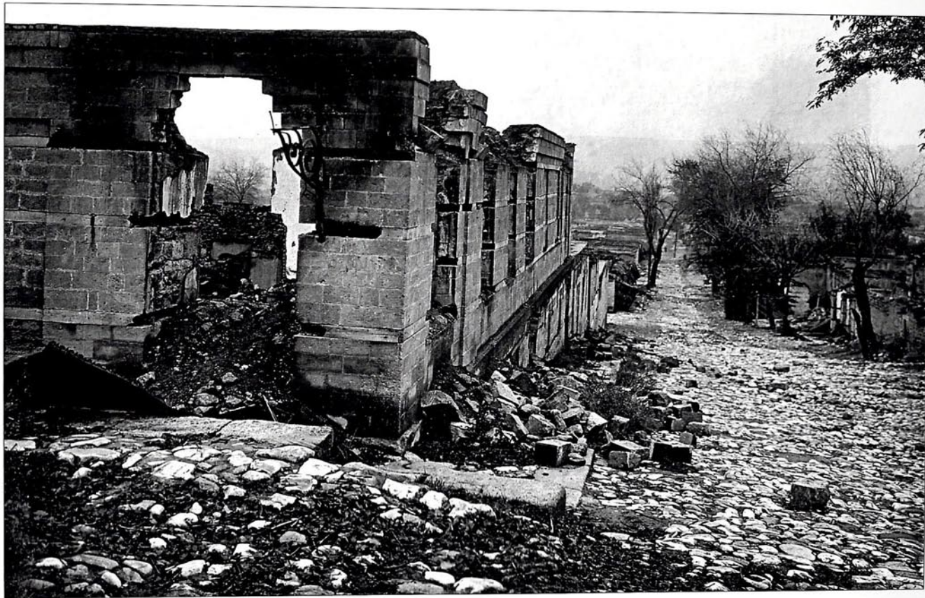
Kupeçeskaya küçasında Hacı Həsənin evinin dağıntıları.
