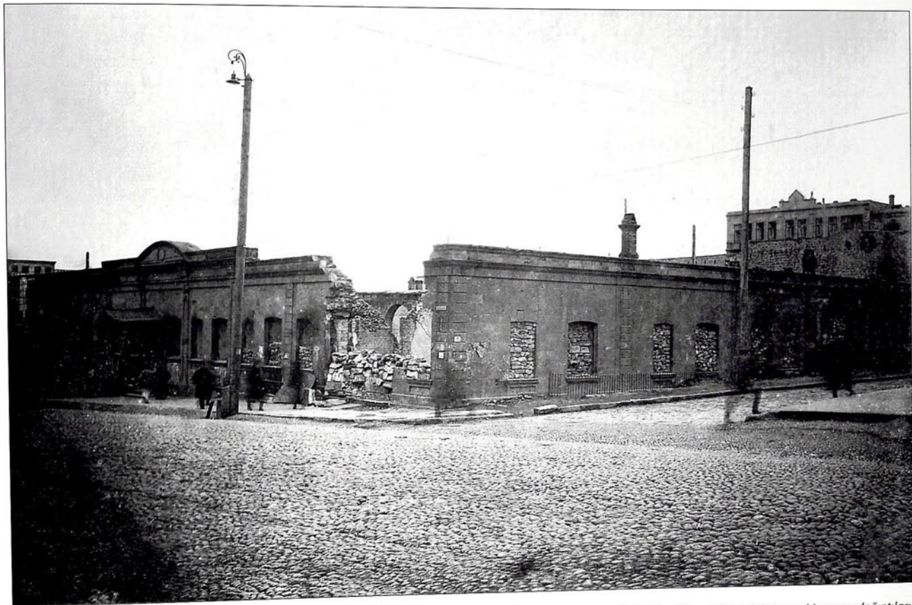
Bakı şəhərində Nikolayevskaya küçəsində "Kaspi" qəzeti redaksiyasının binasının dağıntıları.
