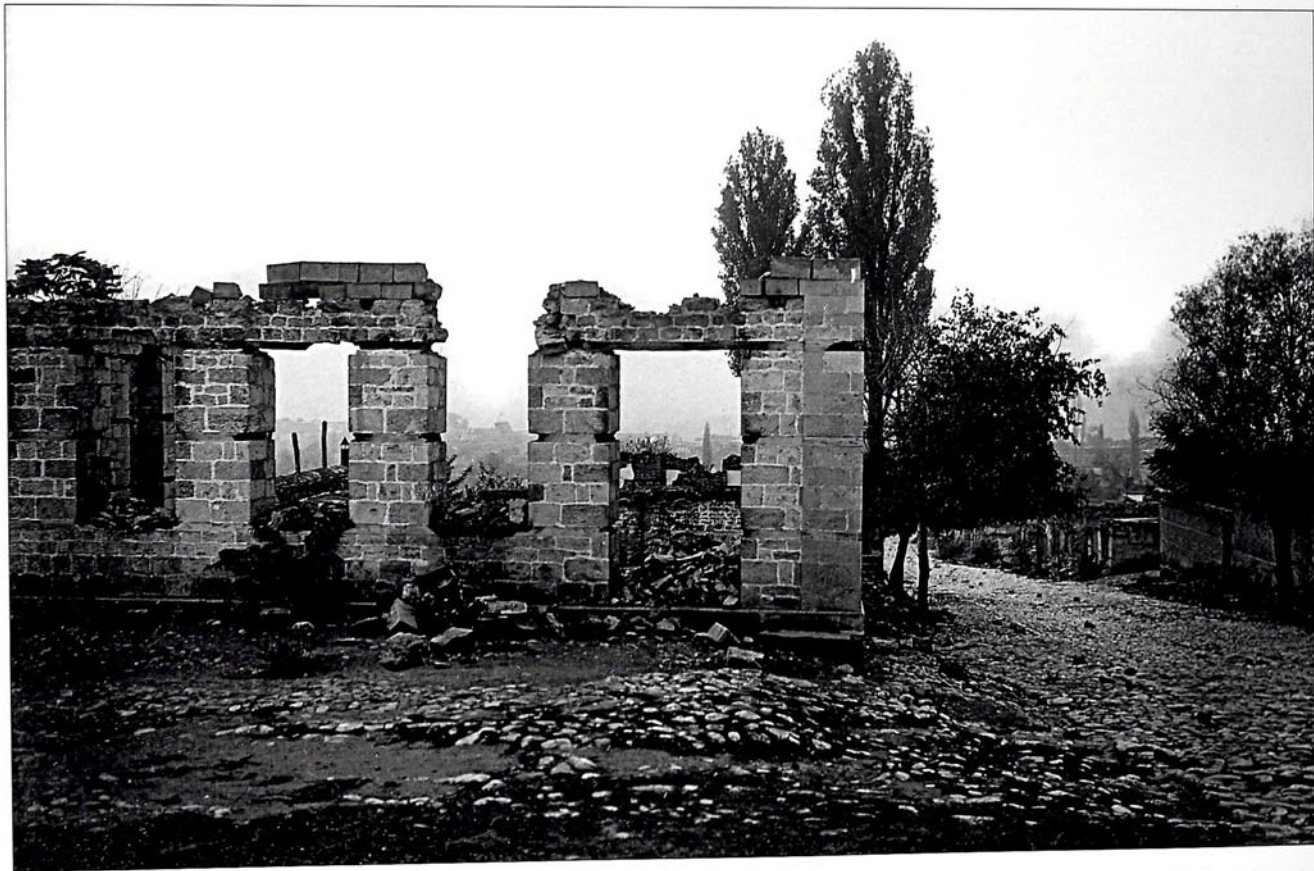
Qoşabulaq və Gürcübazar küçələrinin tinində yerləşən evin dağıntıları və ətrafdakı xarabazartlıq.
