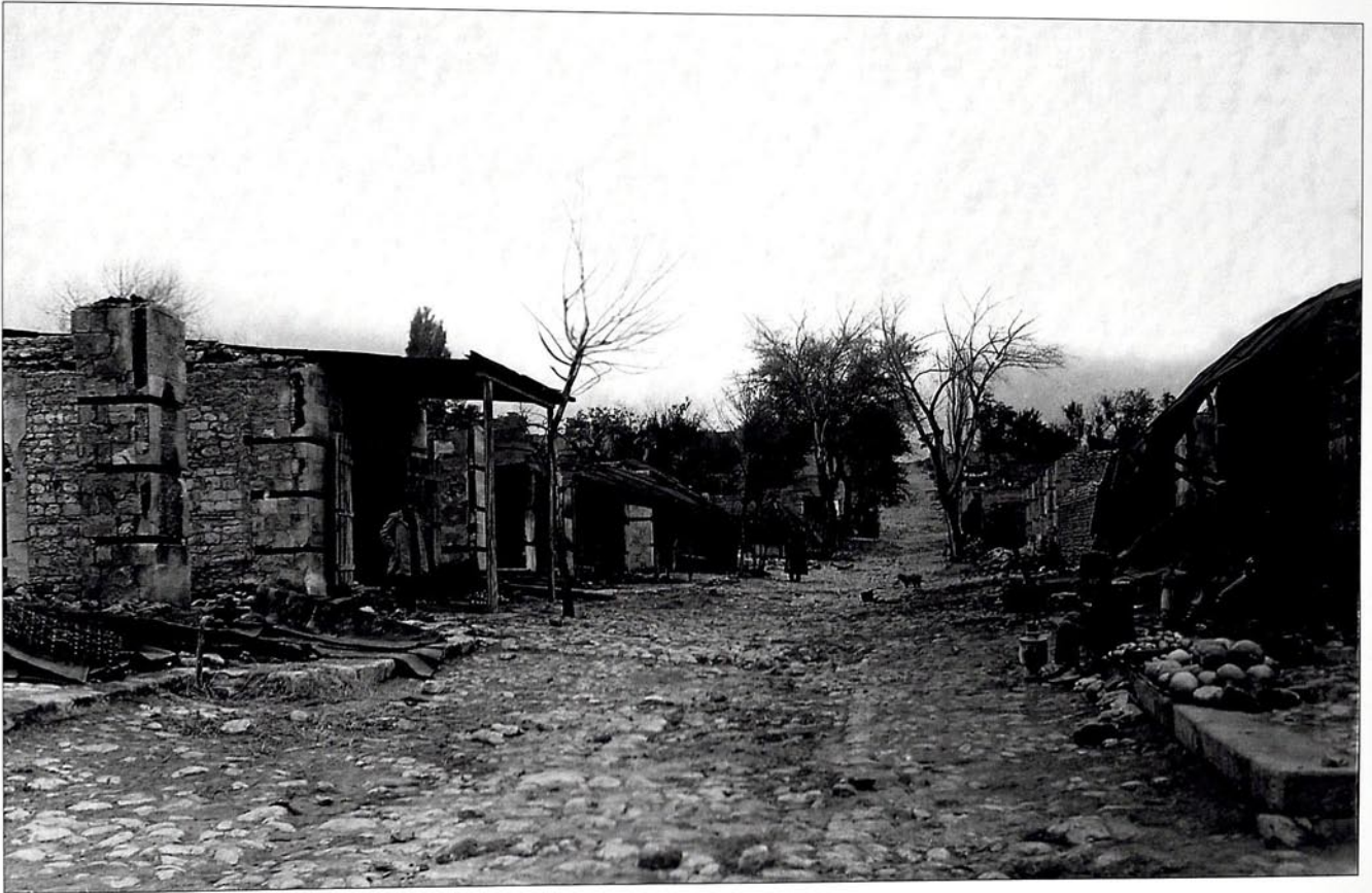
Bolşaya Bazarnaya küçəsində dükanların dağıntıları.
