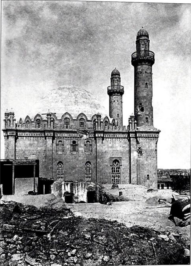
Bakı şəhərində Təzəpir məscidinin top mərmilərindən dağıdılmış binasının cənub tərəfdən görünüşü.
