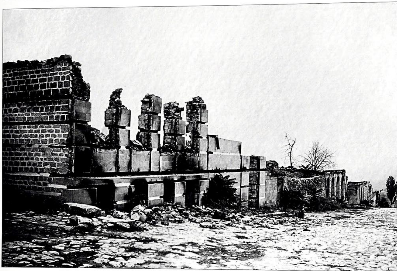
Kupeçeskaya kütəsində Hacı Dadaş Əli-Mirzəyev evinin dağıntıları.
