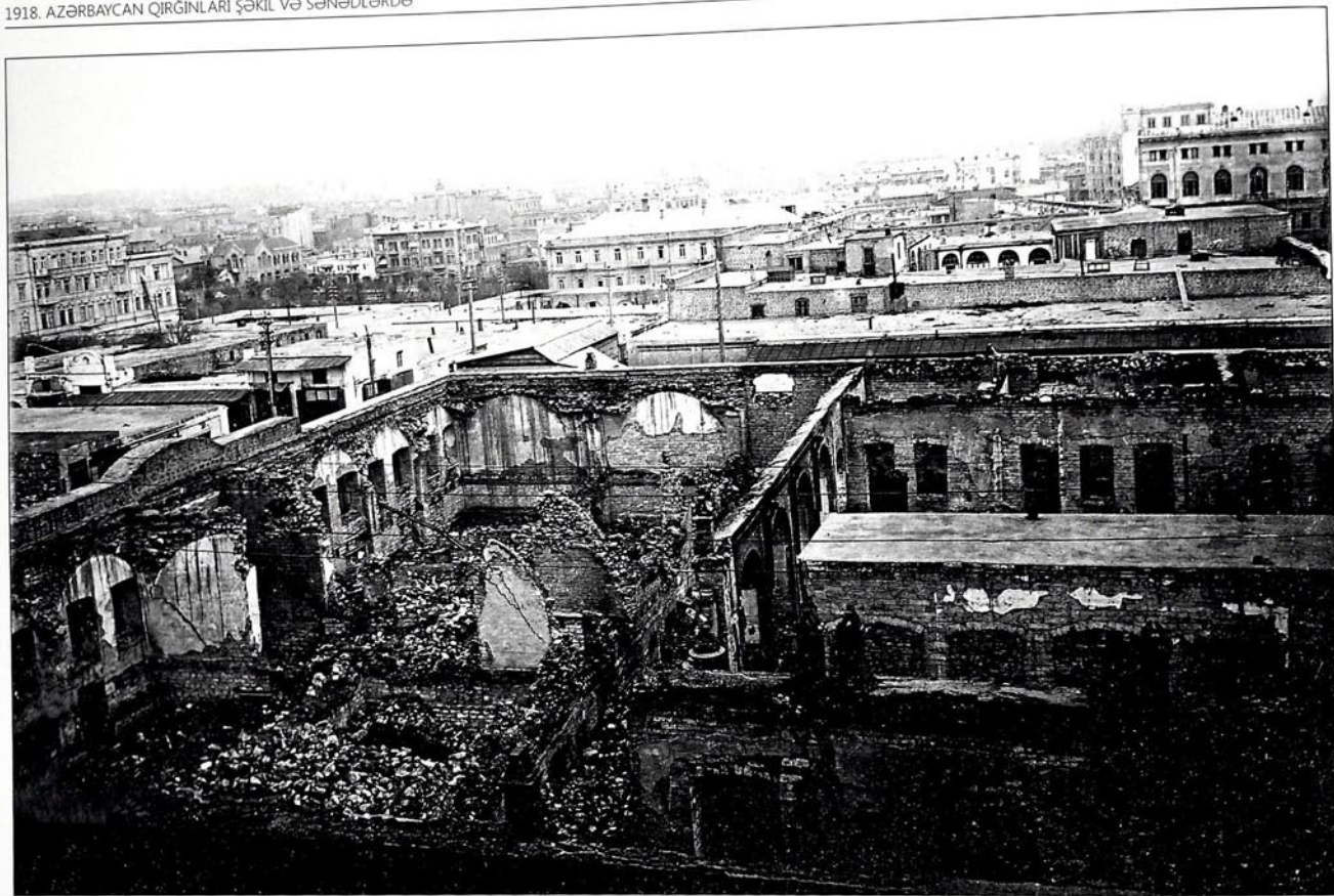
Bakı şəhərində Nikolayevskaya küçəsində "Kaspi" qəzeti redaksiyası binasının yanğından sonra daxili görünüşü.
