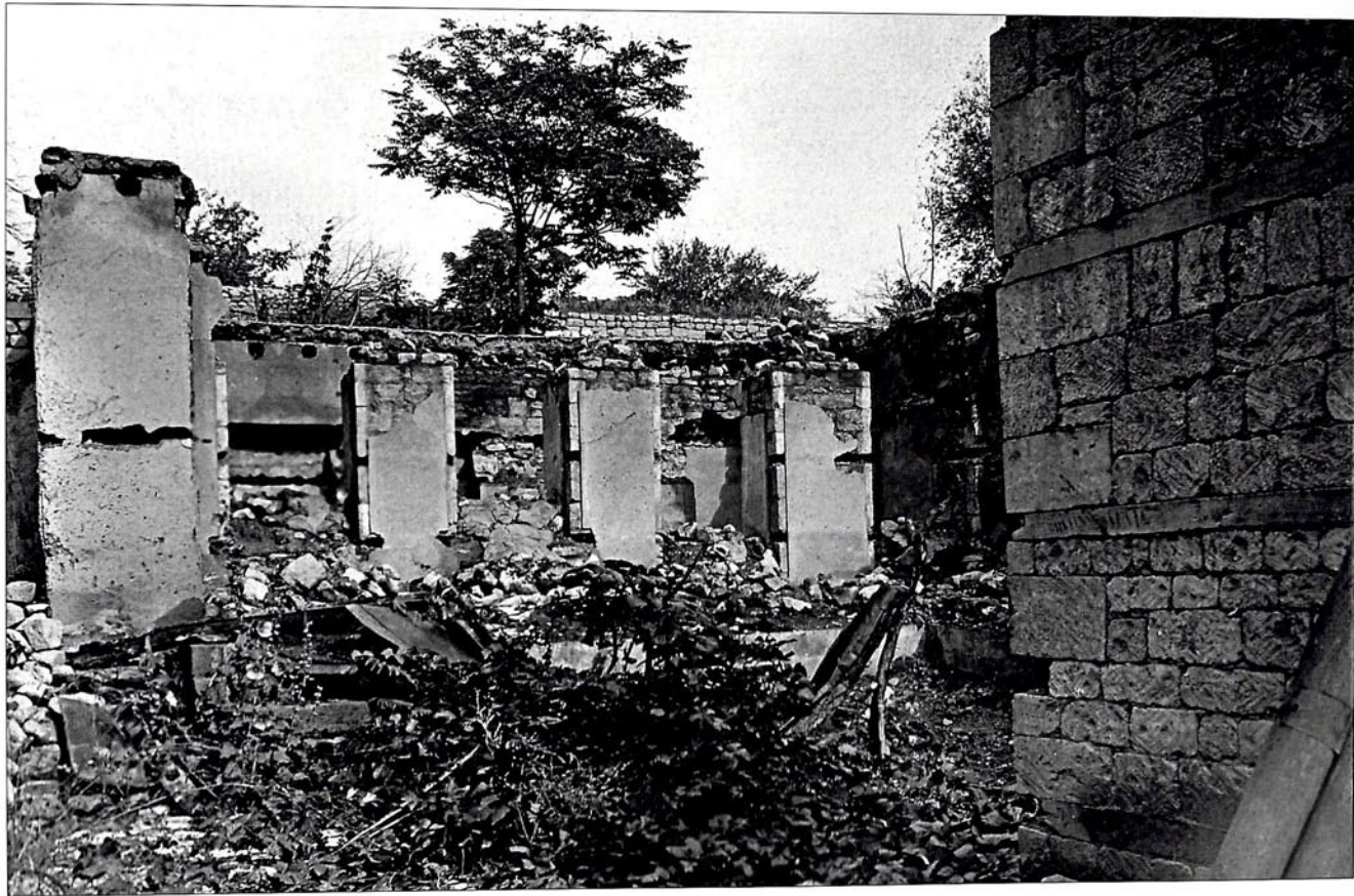
"Şixminas" bölməsində Cəfər-Qulu Axundovun evinin dağıntıları.
