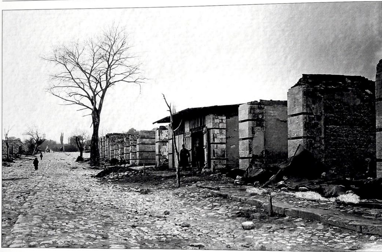
Bolşaya Bazarnaya küçəsində dükanların dağıntıları.
