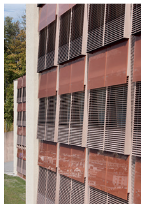
Teilsicht erneuerte Fassade heute (Foto: Ralph Feiner, Malans).
