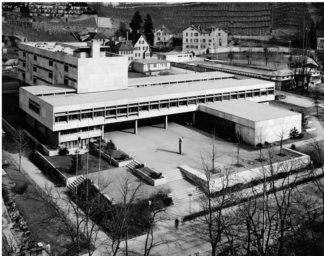
Haus Cleric, historische Luftaufnahme von Südwesten (Foto: Henn, Staatsarchiv Graubünden, Chur, XXI d D 75).
