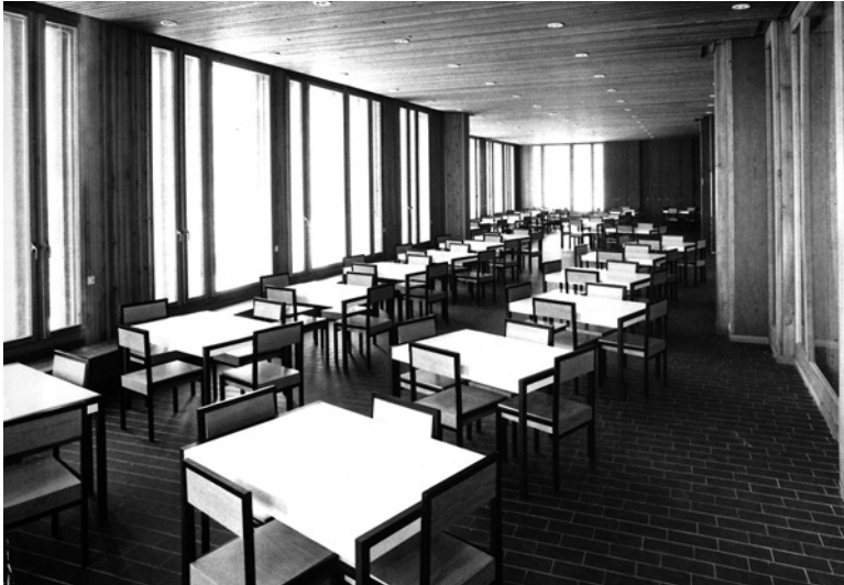
Konvikt, historische Ansicht des Speisesaals und des Treppenhauses (Archiv gta, ETH Zürich).
