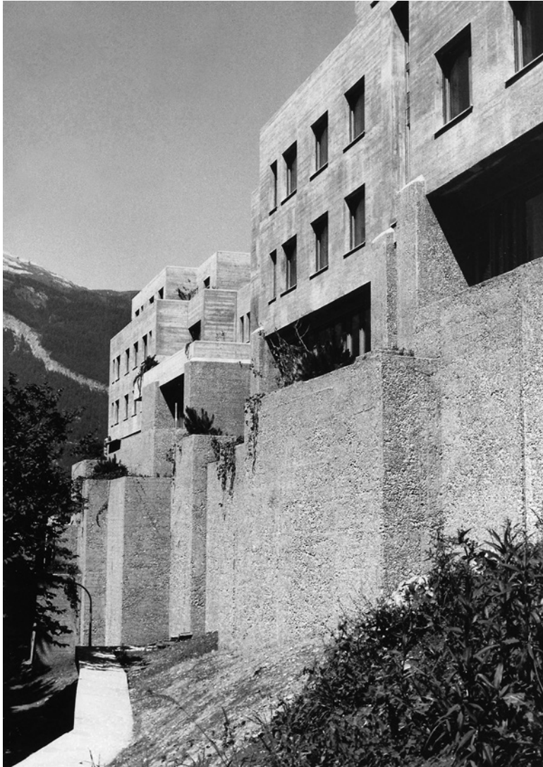
Konvikt, historische Teilansicht von Süden (Archiv gta, ETH Zürich).
