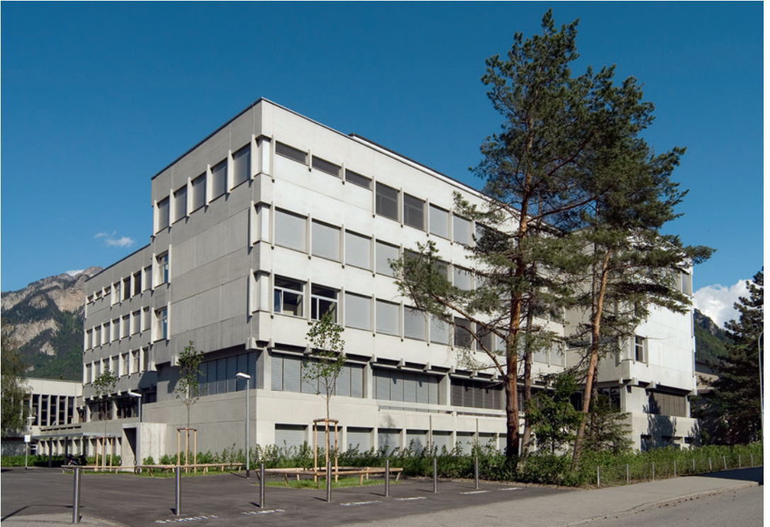
Gewerbeschule, Ansicht von Westen heute (Foto: Lukas Frei, Chur/Mediathek Graubünden [Sammlung Cronica]).
