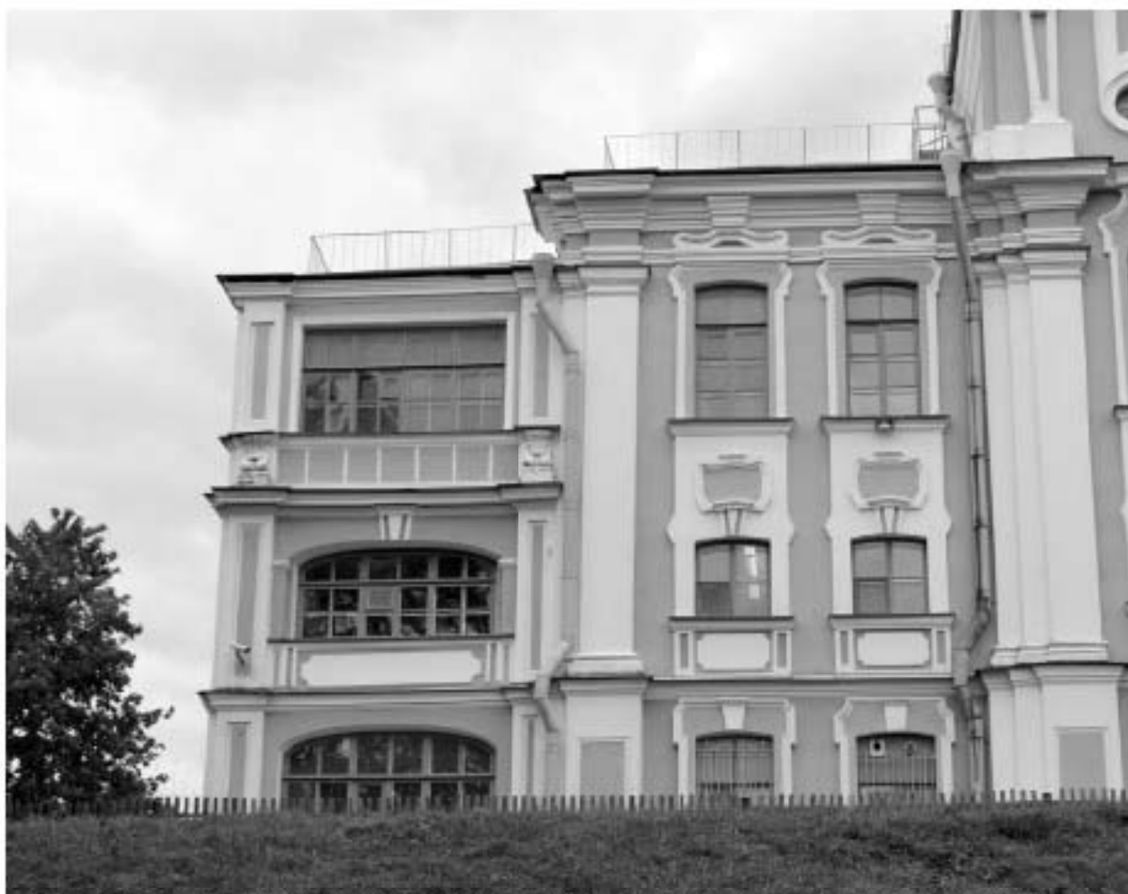
Фото 18. ОКН федерального значения «Главный дом», входящего в состав ОКН федерального значения «Дача Воронцова «Новознаменка». Северный фасад. Фрагмент. Съёмка 10.09.2019 г.
