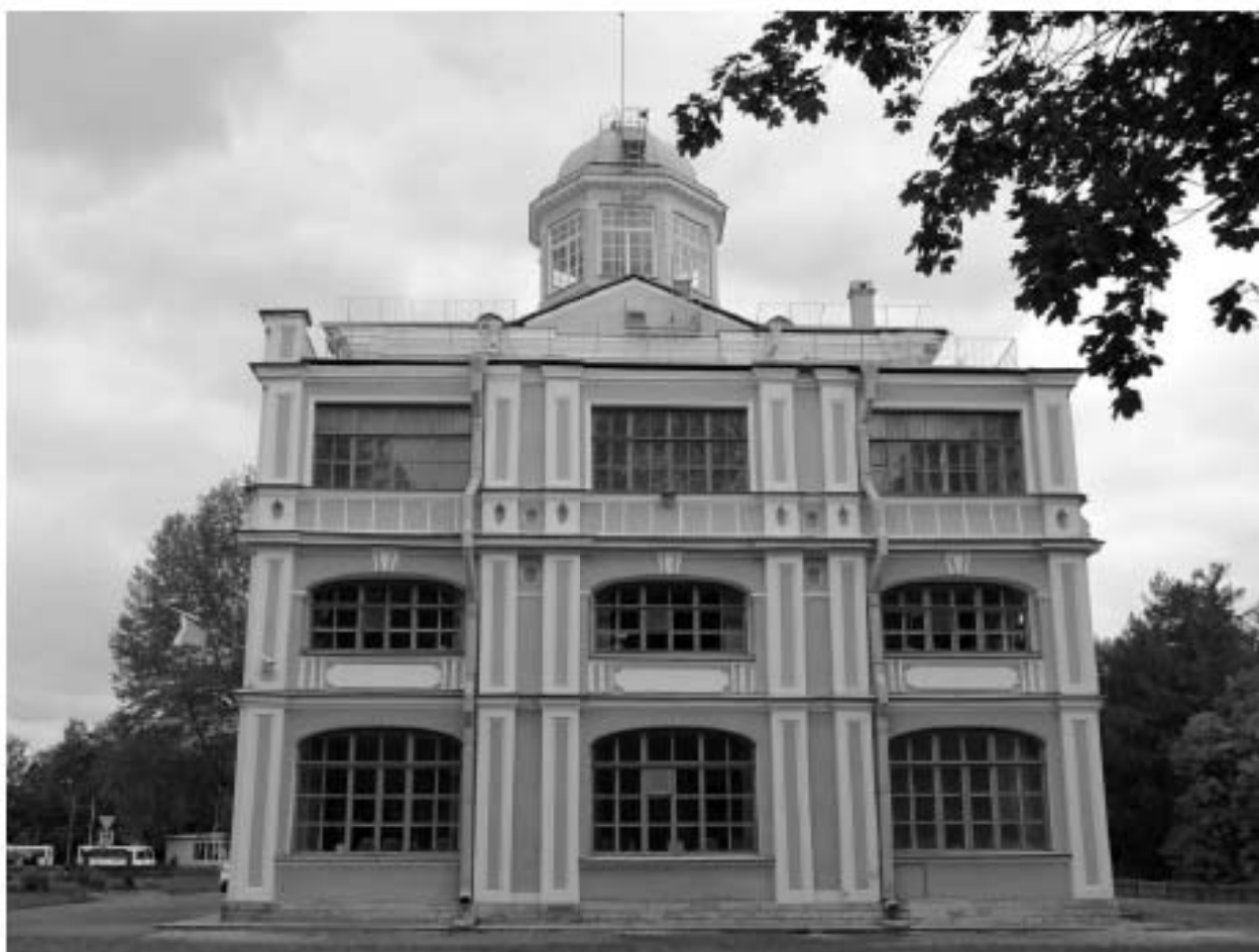
Фото 10. ОКН федерального значения «Главный дом», входящего в состав ОКН федерального значения «Дача Воронцова «Новознаменка». Восточный фасад. Общий вид. Съёмка 10.09.2019 г.
