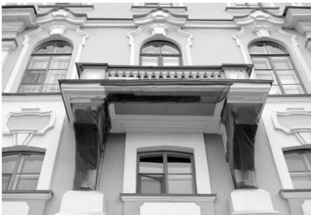
Фото 04. ОКН федерального значения «Главный дом», входящего в состав ОКН федерального значения «Дача Воронцова «Новознаменка». Южный фасад. Фрагмент. Балкон. Съёмка 10.09.2019 г.
