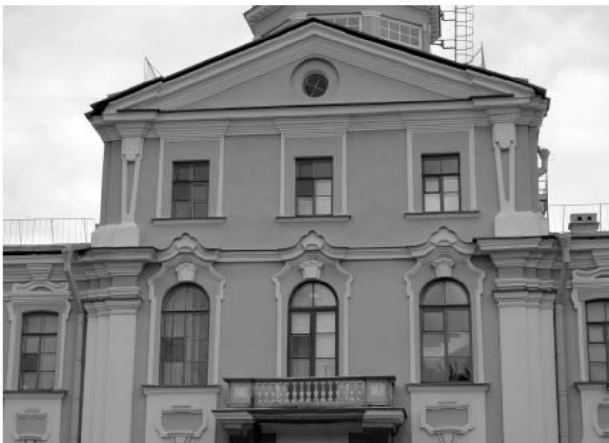
Фото 03. ОКН федерального значения «Главный дом», входящего в состав ОКН федерального значения «Дача Воронцова «Новознаменка». Южный фасад. Фрагмент. Съемка 10.09.2019 г.
