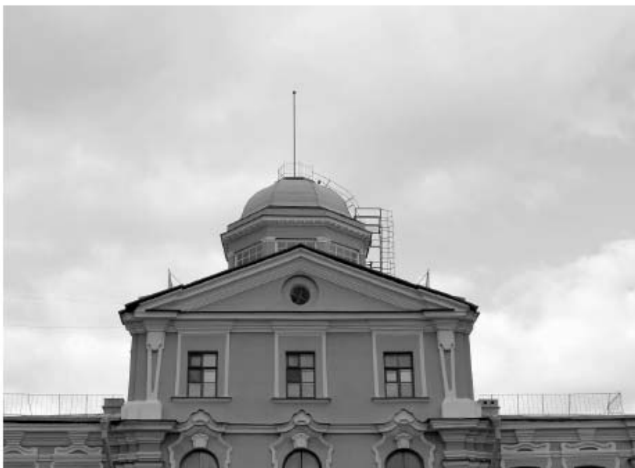
Фото 02. ОКН федерального значения «Главный дом», входящего в состав ОКН федерального значения «Дача Воронцова «Новознаменка». Южный фасад. Фрагмент. Съемка 10.09.2019 г.
