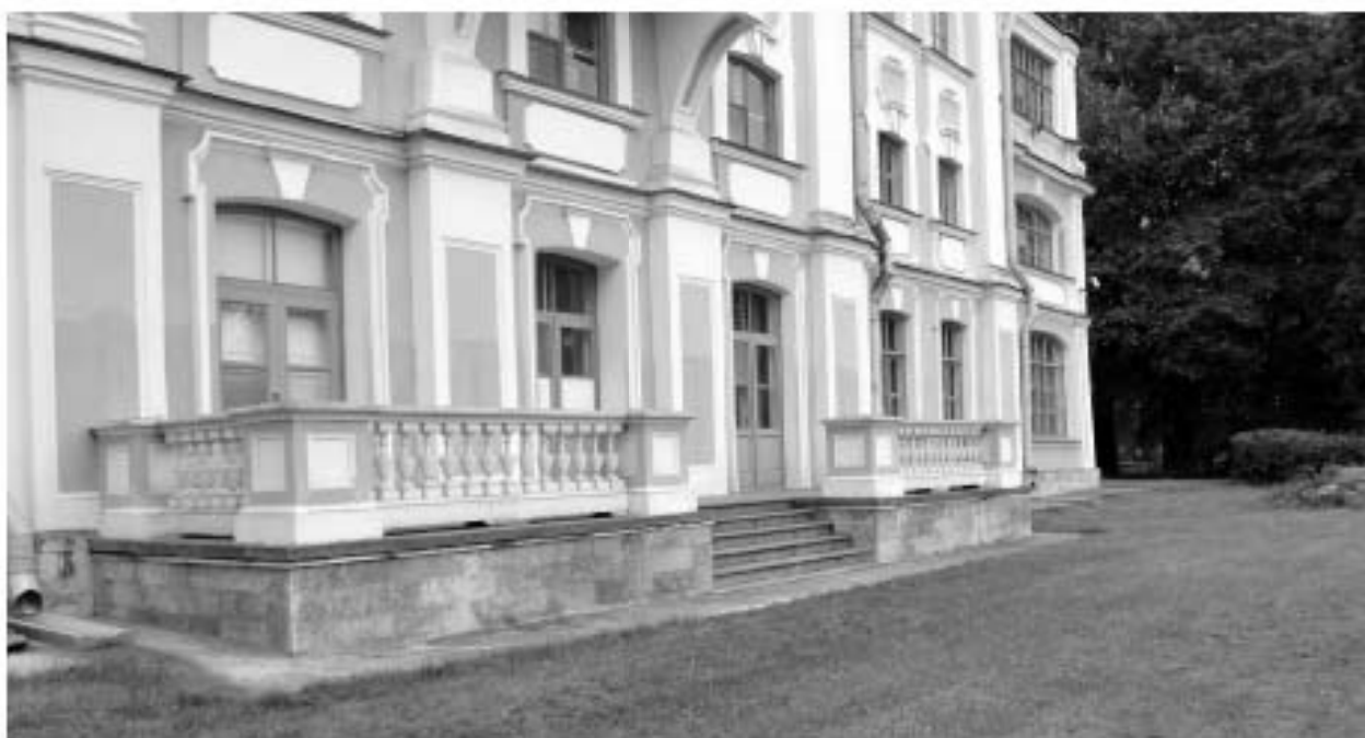
Фото 17. ОКН федерального значения «Главный дом», входящего в состав ОКН федерального значения «Дача Воронцова «Новознаменка». Северный фасад. Фрагмент. Съёмка 10.09.2019 г.
