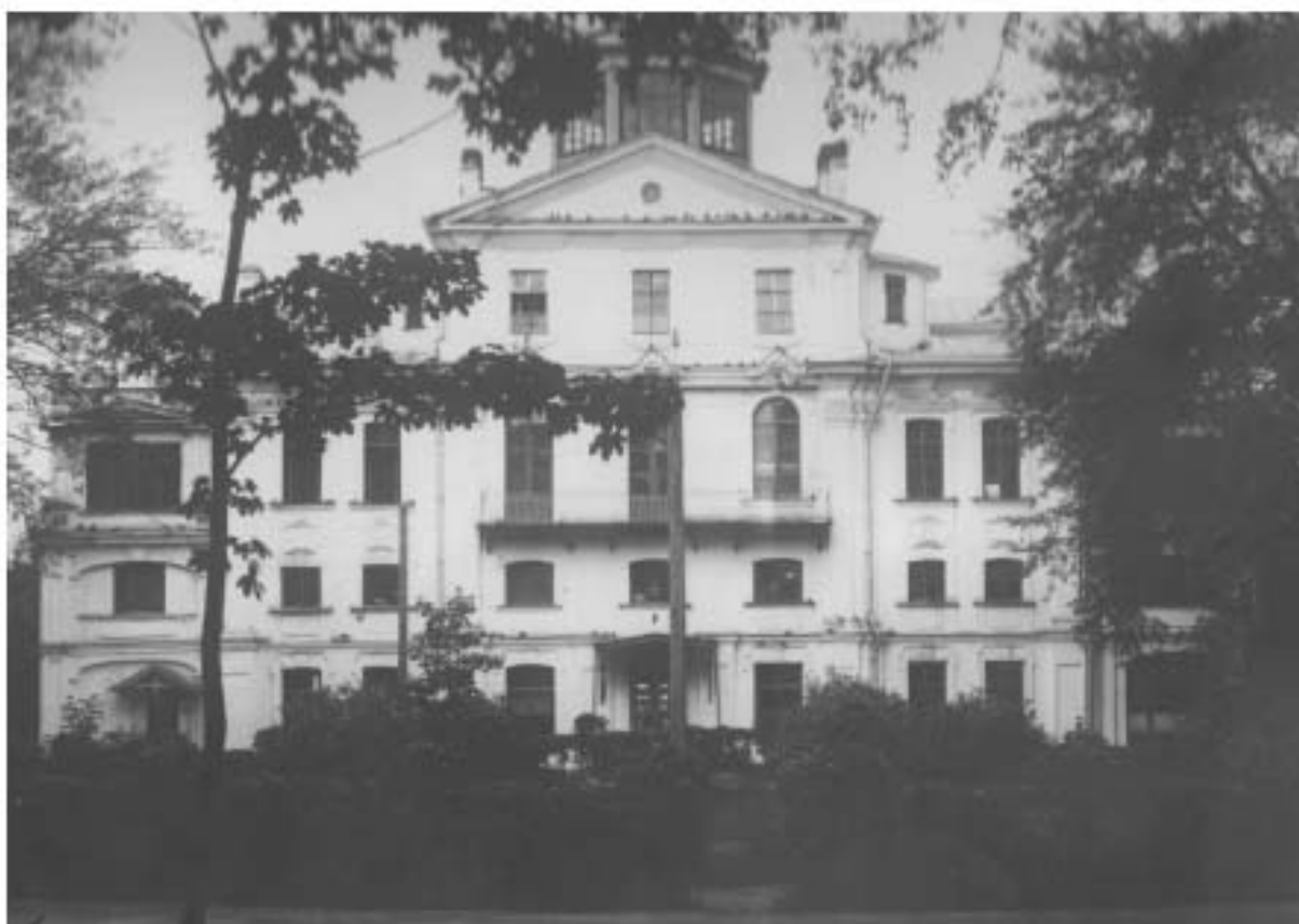
7. Вид на главное здание дачи Воронцова "Новознаменка". Южный фасад. Кон. 1930-х гг. Архив КГИОП. П. 274.
