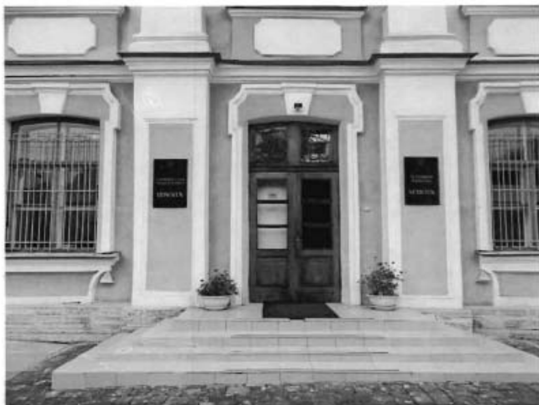
3. Центральный вход со стороны южного фасада.
