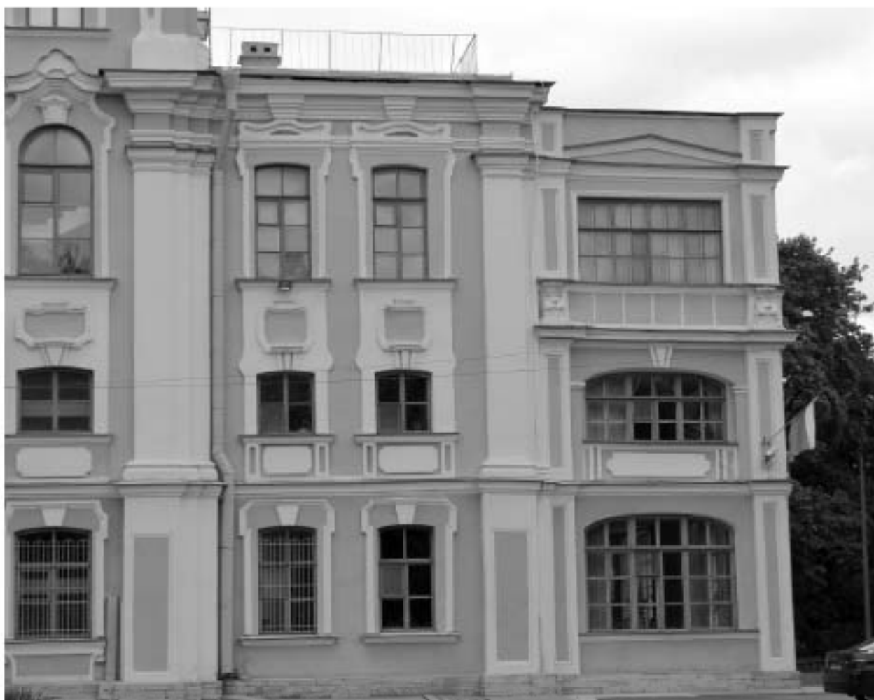
Фото 09. ОКН федерального значения «Главный дом», входящего в состав ОКН федерального значения «Дача Воронцова «Новознаменка». Южный фасад. Фрагмент. Съемка 10.09.2019 г.
