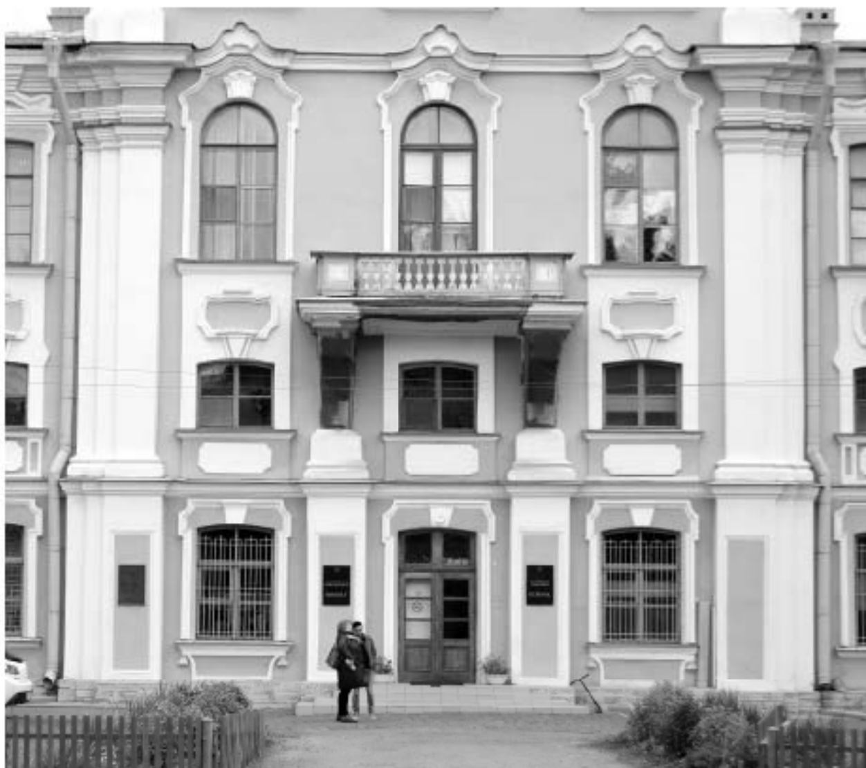
Фото 05. ОКН федерального значения «Главный дом», входящего в состав ОКН федерального значения «Дача Воронцова «Новознаменка». Южный фасад. Фрагмент. Съемка 10.09.2019 г.
