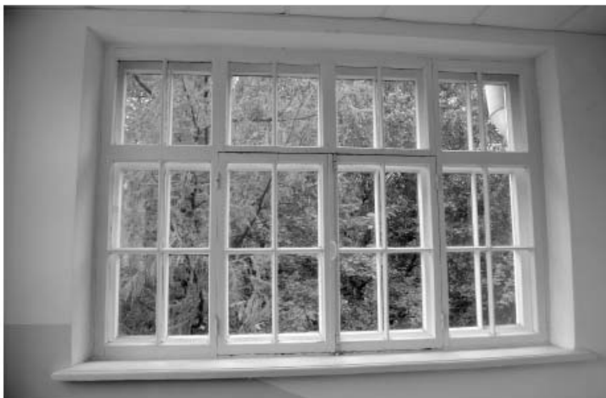
Фото 27. ОКН федерального значения «Главный дом», входящего в состав ОКН федерального значения «Дача Воронцова «Новознаменка». Западный фасад. Фрагмент. Оконные заполнения. Вид с лестничной площадки 3-го этажа. Съёмка 10.09.2019 г.
