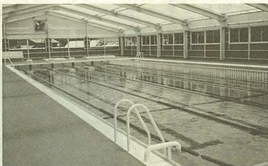
糠内小学校に建設されたプール
