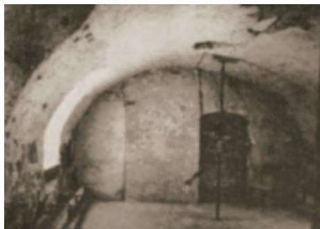
In diesem Keller im «Sternen» in Wangen befand sich wahrscheinlich ein Teil der alten Badestube. Er wurde 1974 zu einer Taverne umgebaut.
