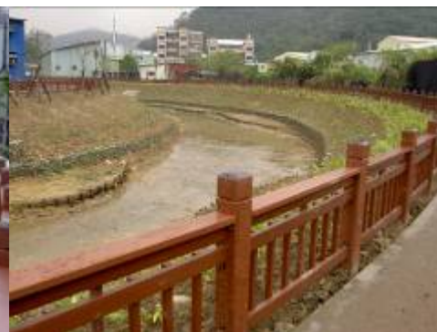
內溝溪右岸堤頂加高
