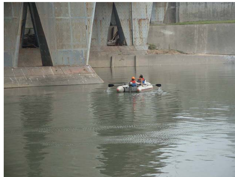
橋樑安全檢測（跨河橋墩檢測）
