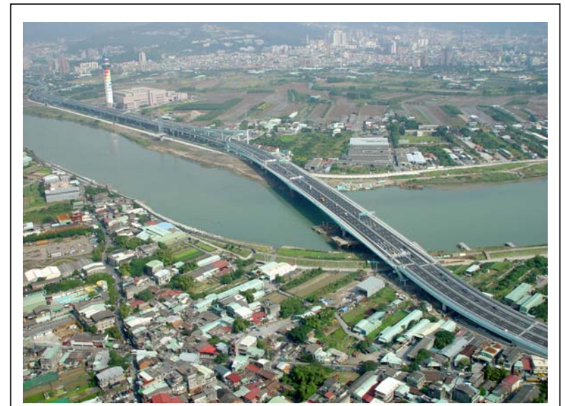
洲美快速道路竣工實況
