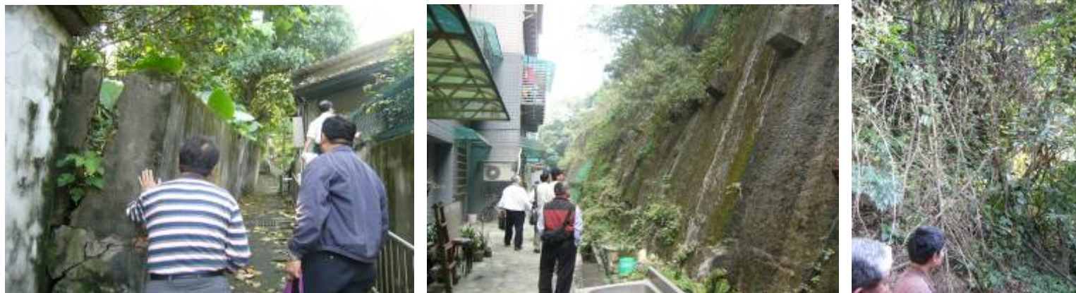
委請專業技師至列管山坡地社區進行安全體檢
