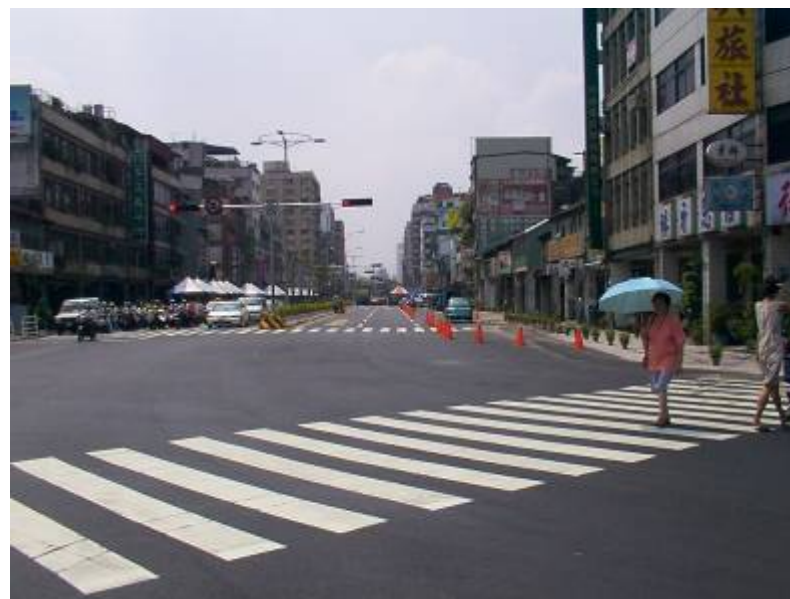
和平陸橋拆除後
