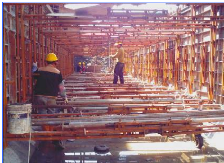
大業路西側段施工中
