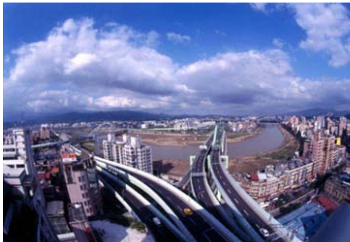
正氣橋完工實況
