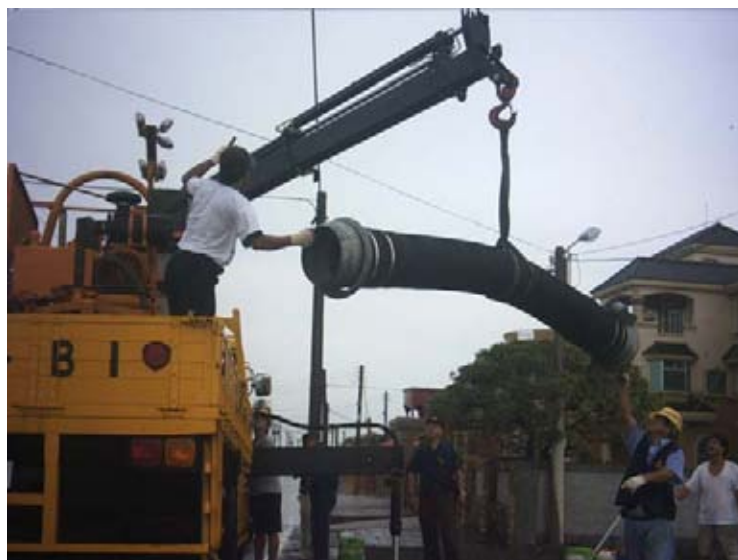
94.07.20 嘉義縣布袋鎮抽水機組安裝作業
