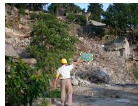
拆除完成照片
