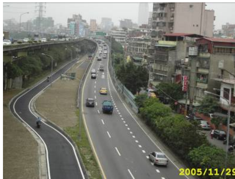
萬華環河快速道路桂林路匝道拆除後
