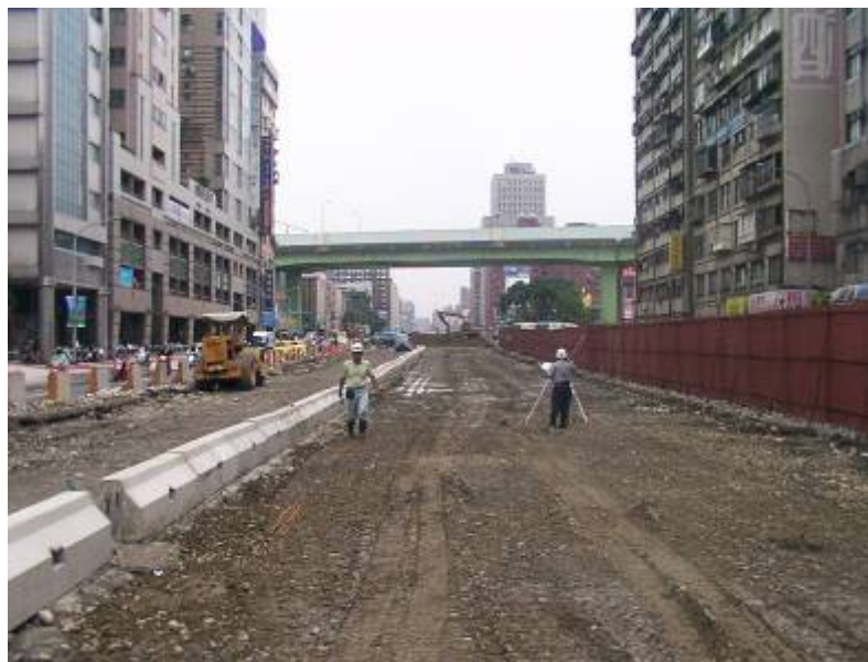
光華橋拆除後
