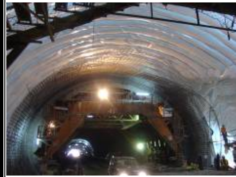
隧道防水膜鋪設現況
