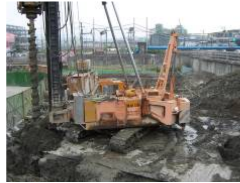
大坑溪誠正國中抽水站工程
