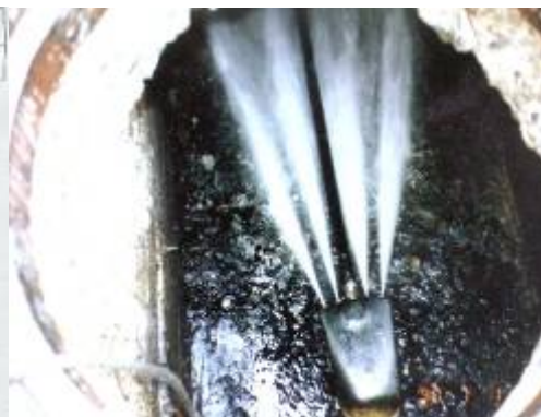
高壓洗管作業
