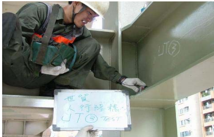
橋樑安全檢測（鋼構漆膜檢測）
