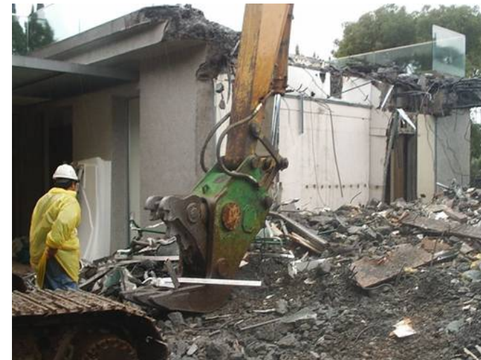
崇仰二路 5 號 2 樓違建拆除現場
