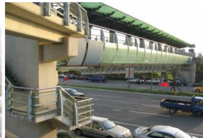
承德路、吉利街口人行陸橋
