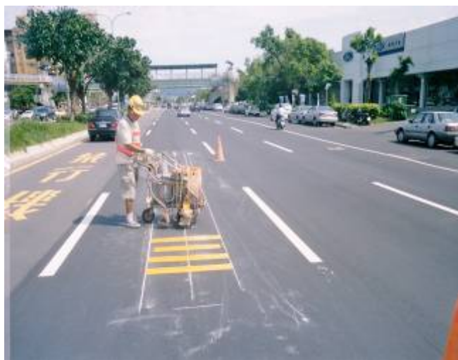
承德路七段道路標線施工
