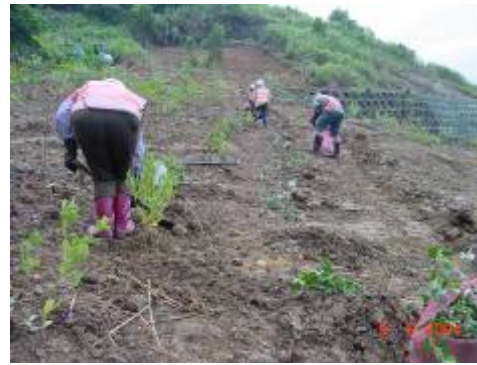
邊坡植栽作業情形
