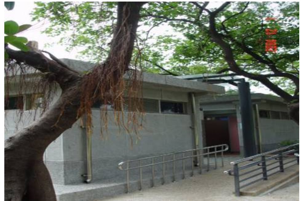
榮星公園更新工程 公廁更新後
