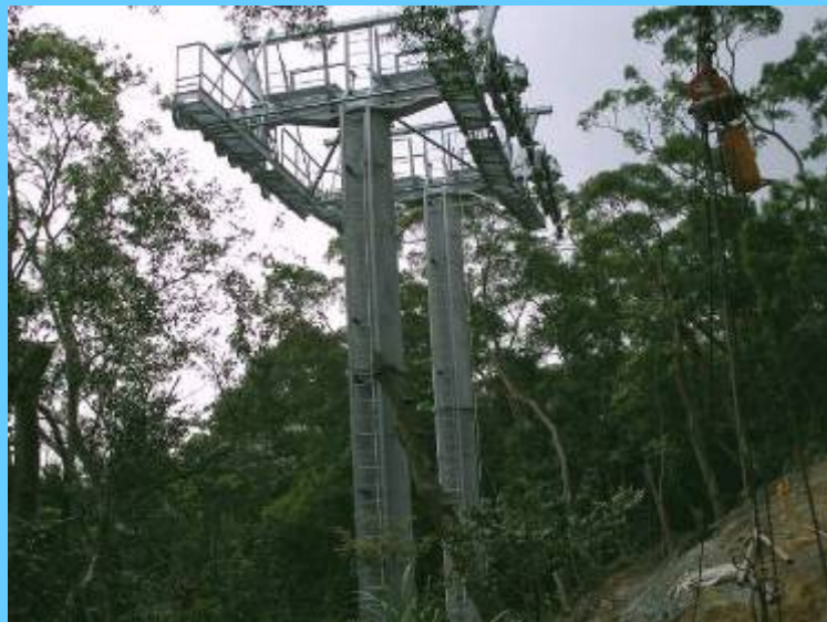
T5 塔柱吊裝完成現況圖
