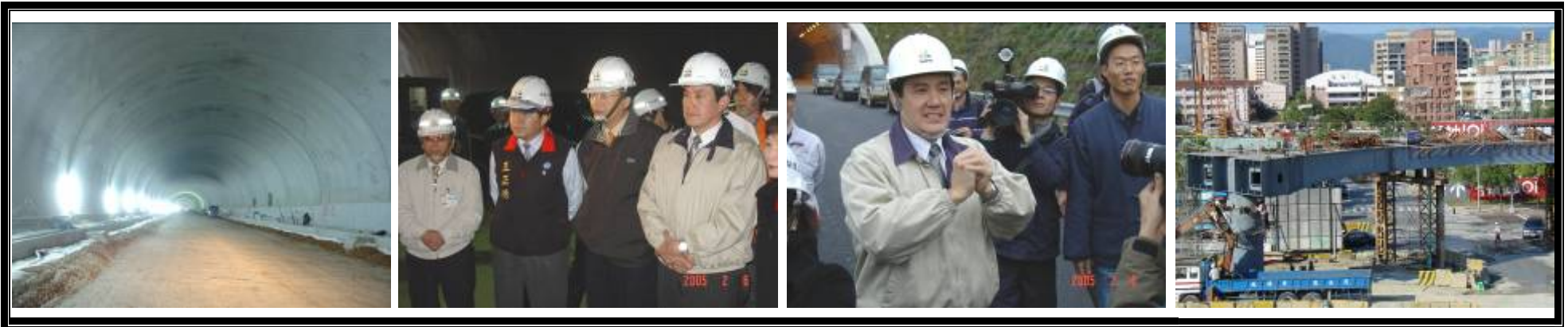
隧道路基鋪設整備情形
