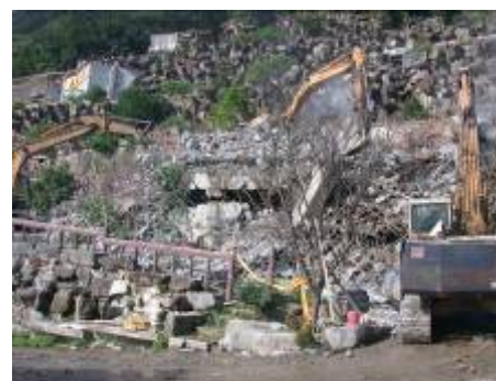
拆除後期照片
