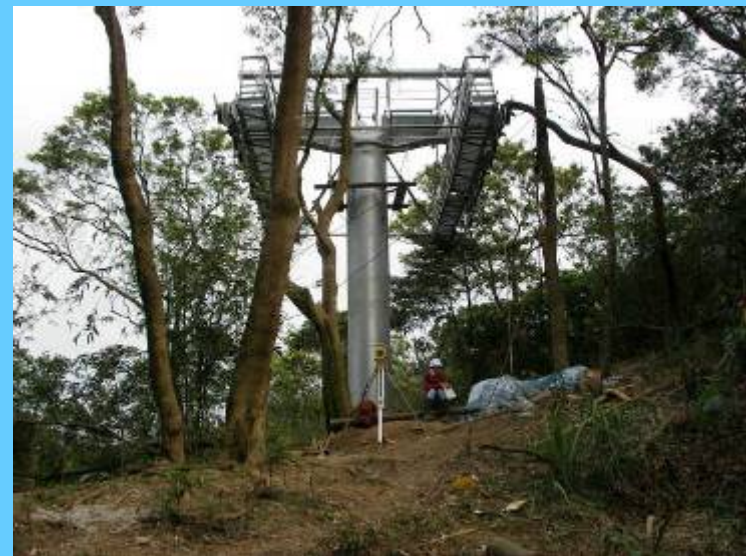
T6 塔柱吊裝完成現況圖
