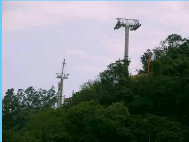
T7 及 T8 塔柱吊裝完成現況圖
