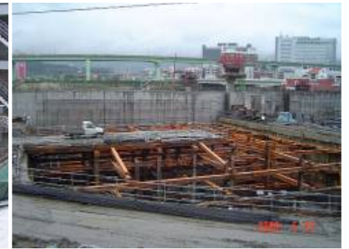
康寧抽水站新建工程
