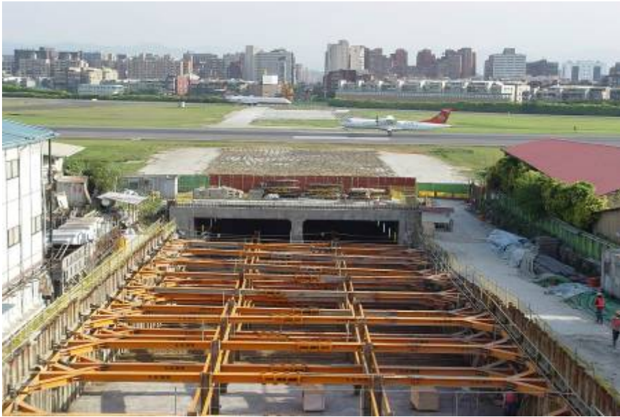
地下道出入口施工照片
