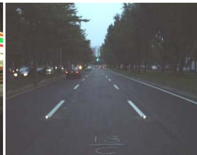
辛亥路一、二段施工完成後
