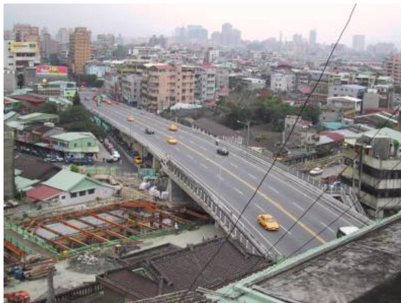
西園陸橋拆除前
