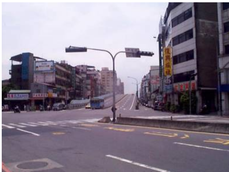
和平陸橋拆除前
