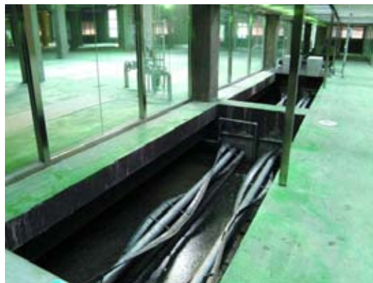
內湖污水處理廠初沉池
