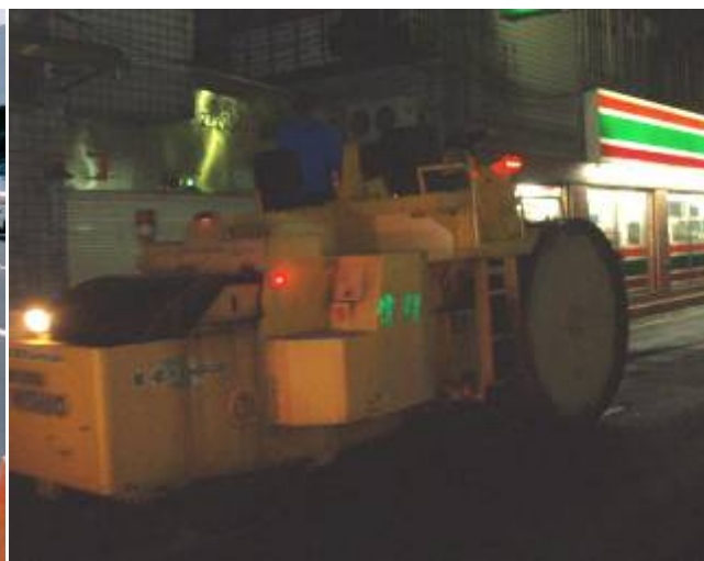
仁愛路四段 450 號旁道路滾壓
