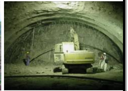
隧道鋼支堡架設情形
