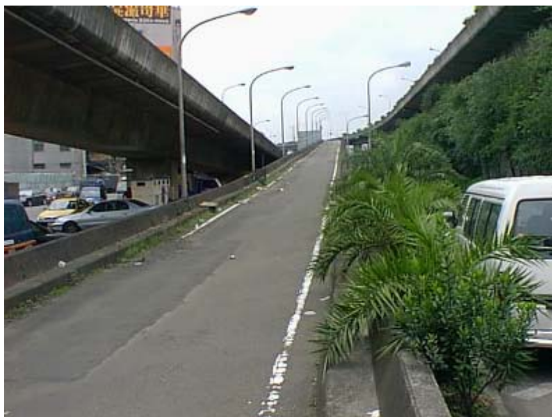
萬華環河快速道路桂林路匝道拆除前
