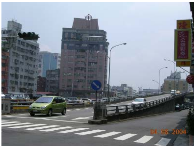
中正愛國陸橋桂林路匝道拆除前
