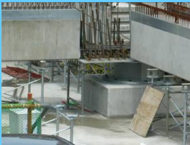
隔震墊實際安裝現況圖
