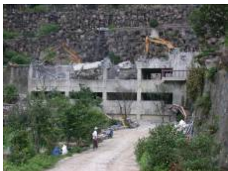
拆除前期照片
