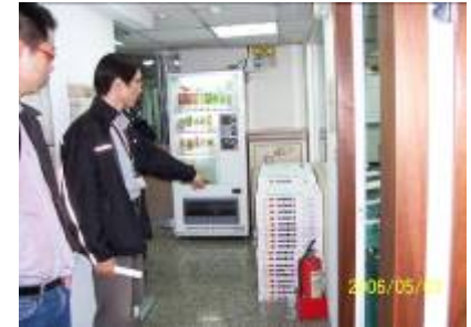
違規事項-逃生走廊 堆積雜物阻礙逃生
