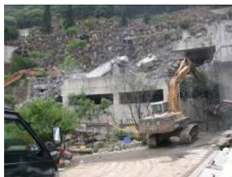
拆除中期照片
