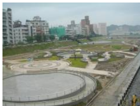
恆光橋右岸河道整治情形
