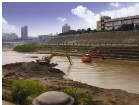
景美溪整治河道清疏
