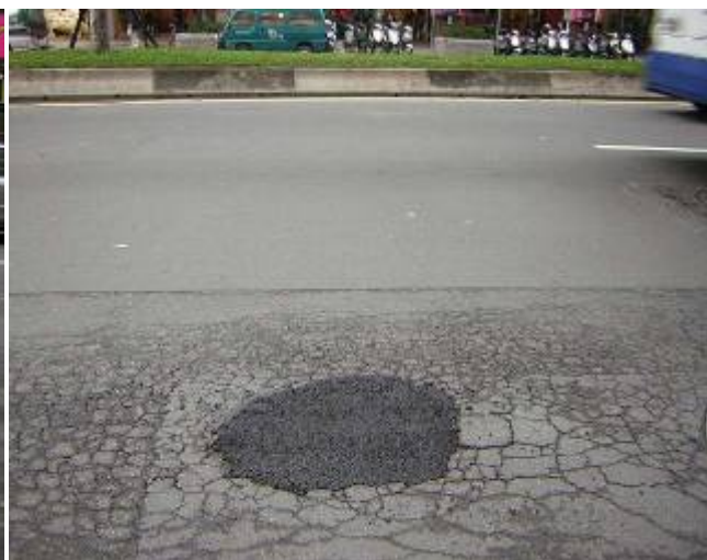
發現坑洞當下立即先以常溫瀝青混凝土填補，填報查報單後再辦理方正銑鋪
