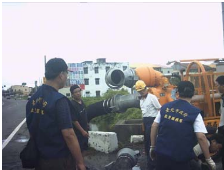
94.07.20 嘉義縣布袋鎮抽水機組安裝作業
