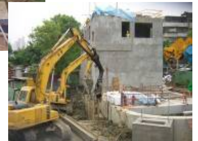
四分溪勤力橋下游抽水站施工中
