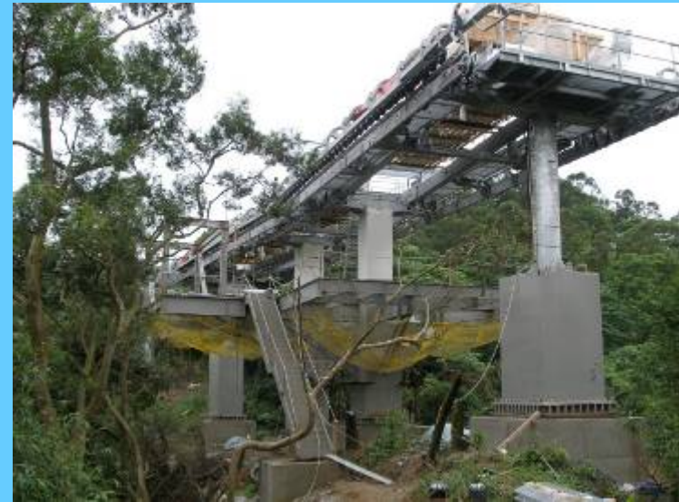
G2 轉角一站場站鋼構件安裝栓緊及調校
