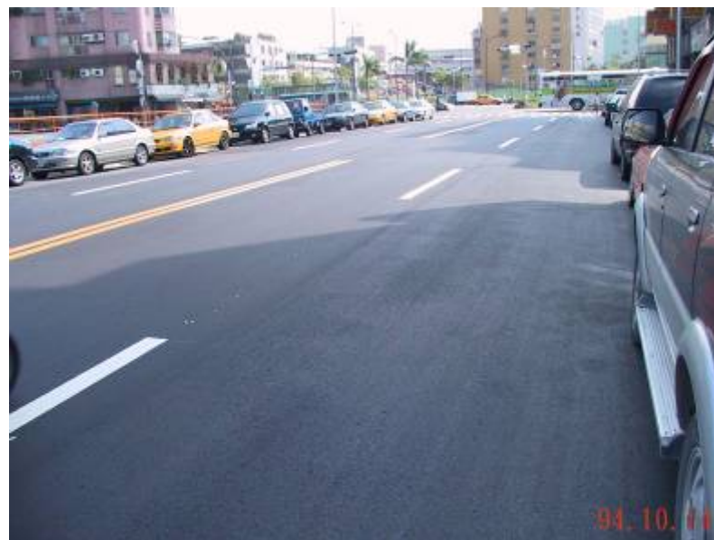
中正愛國陸橋桂林路匝道拆除後
