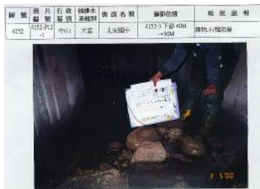
人工縱走調查作業 (發現排水障礙)
