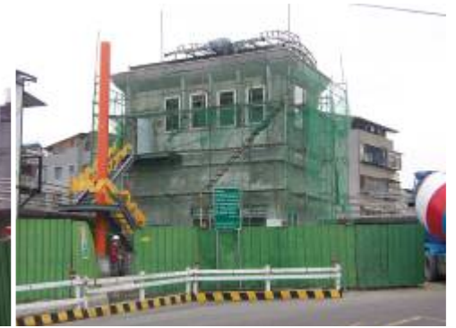
四分溪右岸抽水站工程
