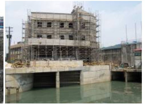
中山抽水站擴建工程
