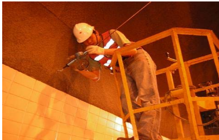
橋樑安全檢測（混凝土強度衝錘檢測）
