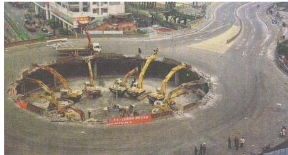
正氣橋拆除時施工實況
