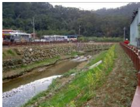
內溝溪整治河道清疏
