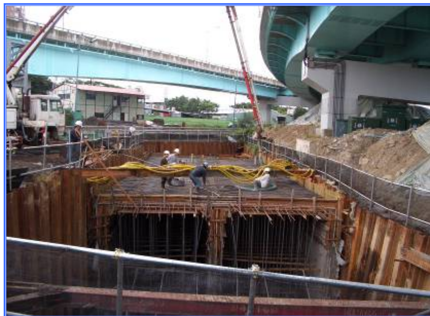
橫越大度路段施工中
