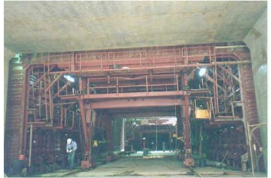
地下道內施工照片
