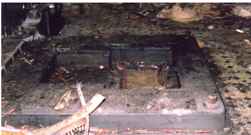
Stav těžního stroje dnes, foto: T. Voldráb
