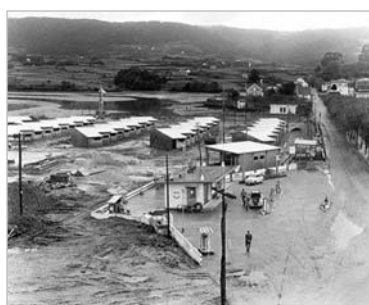
Comezo das obras
