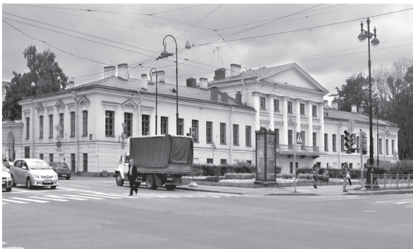
7. Дом португальского консула (Типография Академии наук) на Большом проспекте Васильевского острова, 28. Современное фото (источник: архитектурный сайт Citiwalls)
