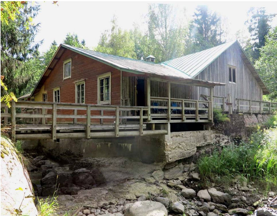
Ingarskilassa on säilynyt 1800-luvun lopulla rakennettu hirsirunkoinen mylly, vanha osa on jätetty 1930-luvulla tehdyn laajennuksen sisään. Lähes kaikki myllyn laitteet ovat säilyneet. Mylly on nykyään yksityisomistuksessa. (IMG_3538p.jpg)
