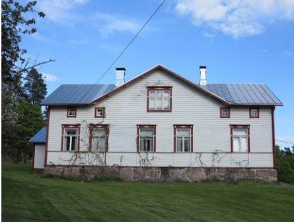
651 Jutansin päärakennus 1800-luvun lopulta.
