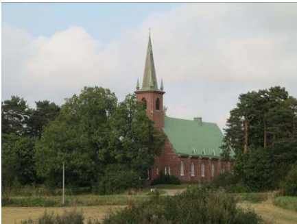
Rautatieaseman luoteispuolella maantien varressa seisoo komeana maisemassa punatiilinen 1925 valmistunut metodistikirkko Tabor (526).
