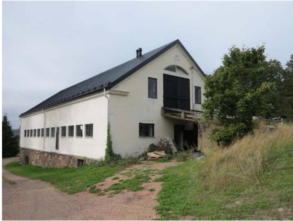
Kalkullan vanhalle lohkokivisokkelille rakennettu sementtitiilinavetta on vuodelta 1939.
