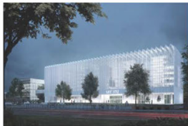
010 - Vue de l'extérieur - Niveau 01/10
