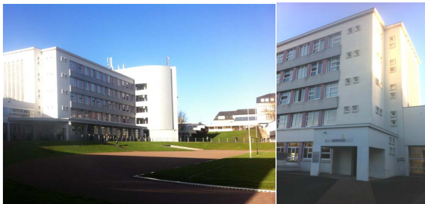
Vues extérieures de l'internat
