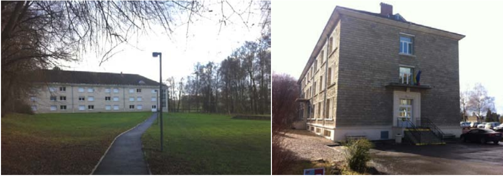
Deux des trois bâtiments qui composent l'internat, au sein de l'ancien site militaire
