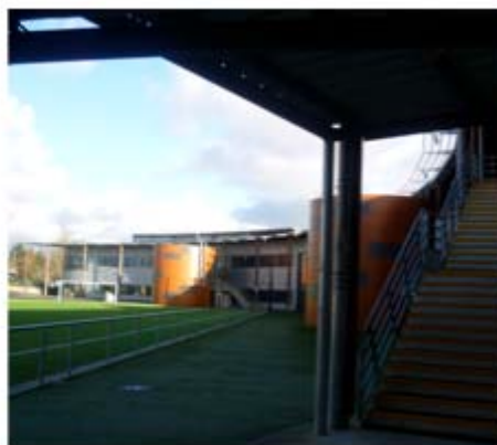
Vue sur le bâtiment scolaire
