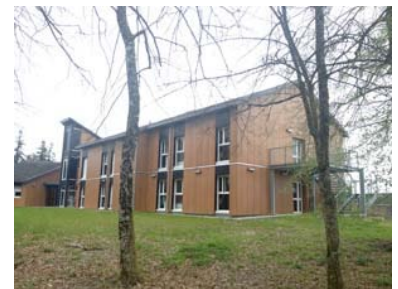
Latresne – Reconversion d'un bâtiment existant
