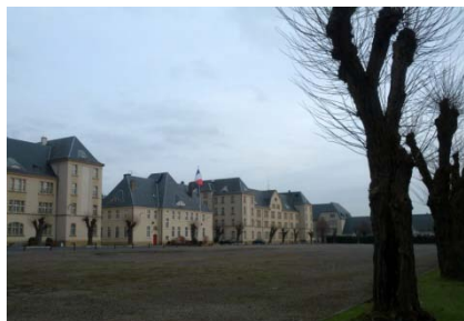
Châtel-Saint-Germain – Reconversion de bâtiments militaires sur un site occupé par deux compagnies de CRS
