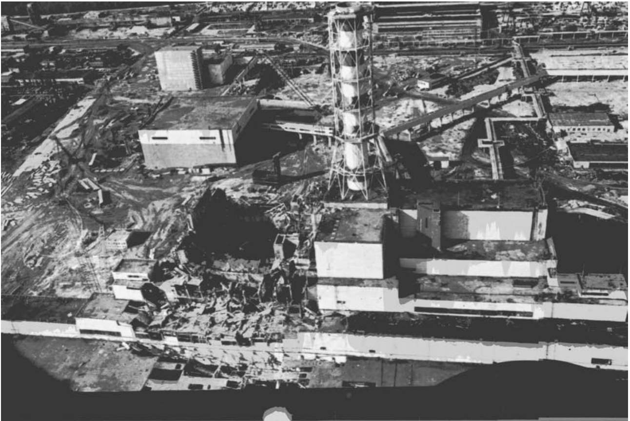
Рис. 7.1. Разрушенный реактор после аварии в 1986 году.
