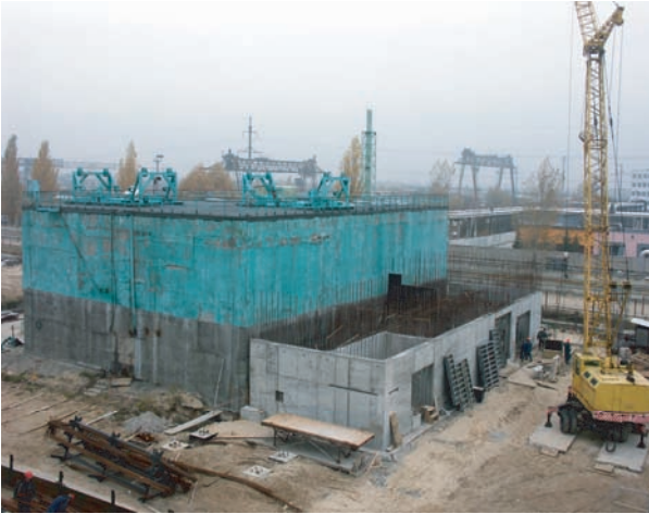
Рис 7.9. Существующее наземное хранилище для твердых радиоактивных отходов на площадке Чернобыльской АЭС.
